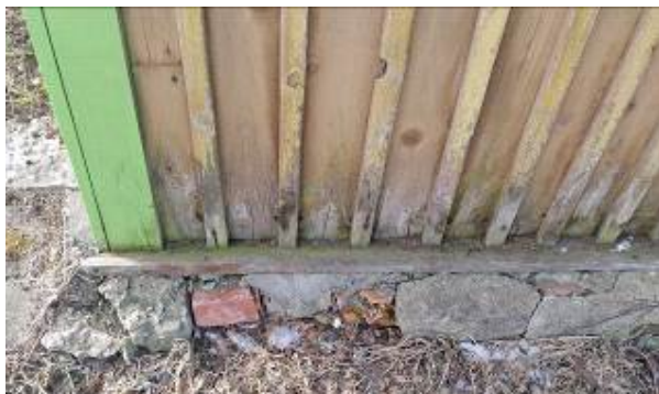
28. Puitkarkass seinaga hooneosa tsementmördiga kaetud sokkel. 27.03.2022. Foto: T. Väikmeri.
