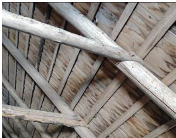
39. Katuse penn-sarikate konstruktsioon ja originaal sindelkate. 27.03.2022. Foto: T. Väikmeri.
