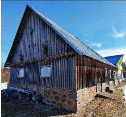
15. Vaade abihoonele läänesuunast. 27.03.2022. Foto: T. Väikmeri.
