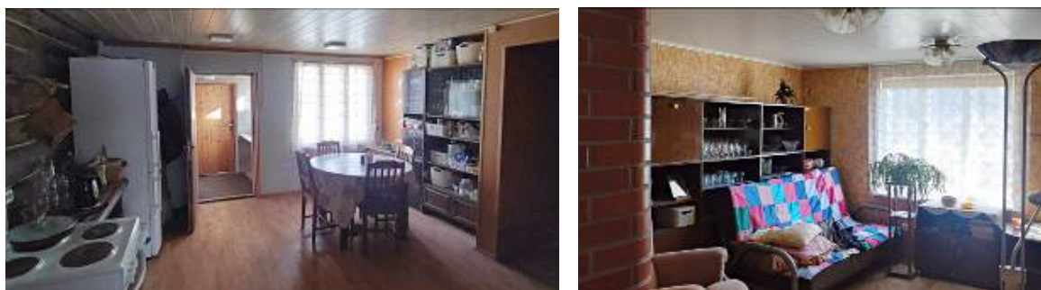
35. Köögis on väljapuhastatud palksein, uus laminaatparkett ja laepaneelid. 27.03.2022. Foto: T. Väikmeri.
