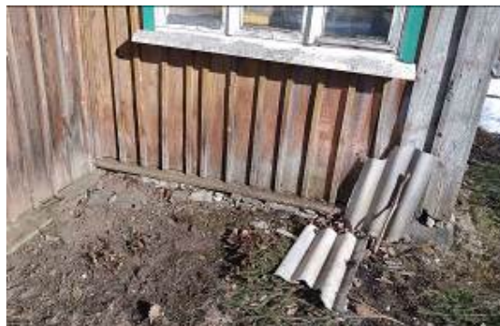
28. Puitkarkass seinaga hooneosa tsementmördiga kaetud sokkel. 27.03.2022. Foto: T. Väikmeri.
