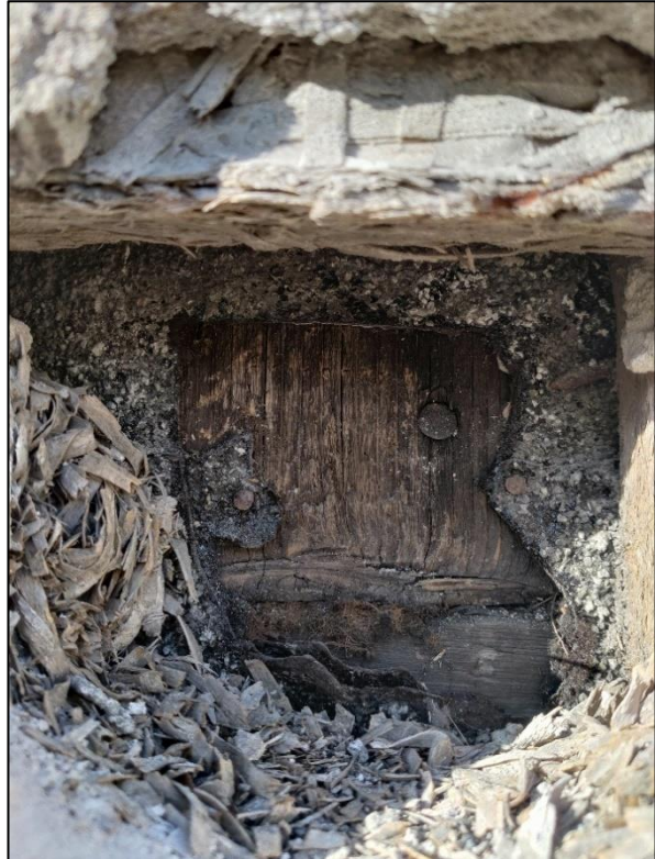
Illustratsioon 26. Tagumises fassaadis olev auk pärast autori sekkuvat uuringut (autori pilt)
