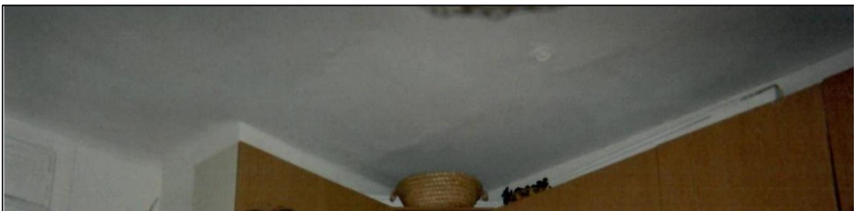
Illustratsioon 20. Peegelvõlvlagi (omanike isiklik pildikogu, pilt autori poolt mugandatud)
