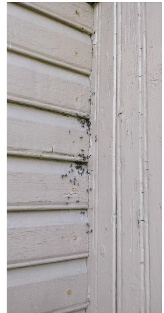
Pilt 19 ja 20. Ulatuslik niiskuskahjustus hoone põhjaküljel ning tõenäoline sipelgapesa välisvoodri aluses tuulutuvahes sarnaselt hoone lõunaservaga 08.2022 (allikas: Autor)
