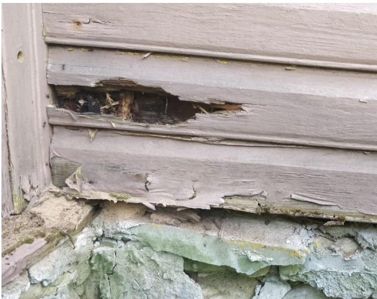
Pilt 19 ja 20. Ulatuslik niiskuskahjustus hoone põhjaküljel ning tõenäoline sipelgapesa välisvoodri aluses tuulutuvahes sarnaselt hoone lõunaservaga 08.2022 (allikas: Autor)
