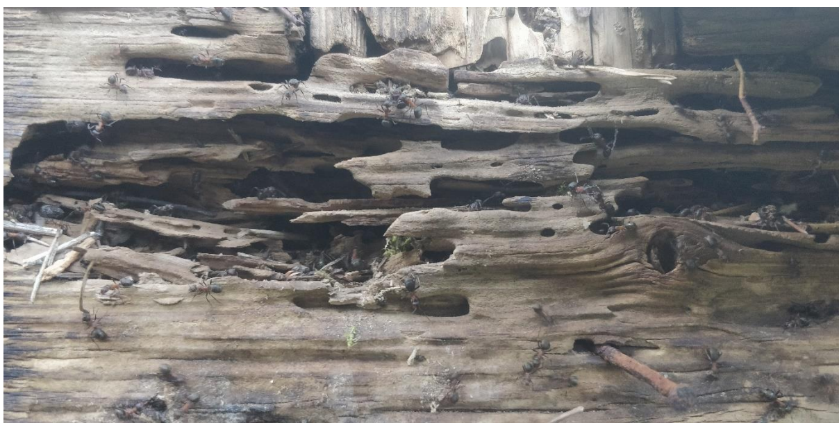
Pilt 17. Sipelgapesa lõunapoolses välisseinas 08.2021 (allikas: Autor)
