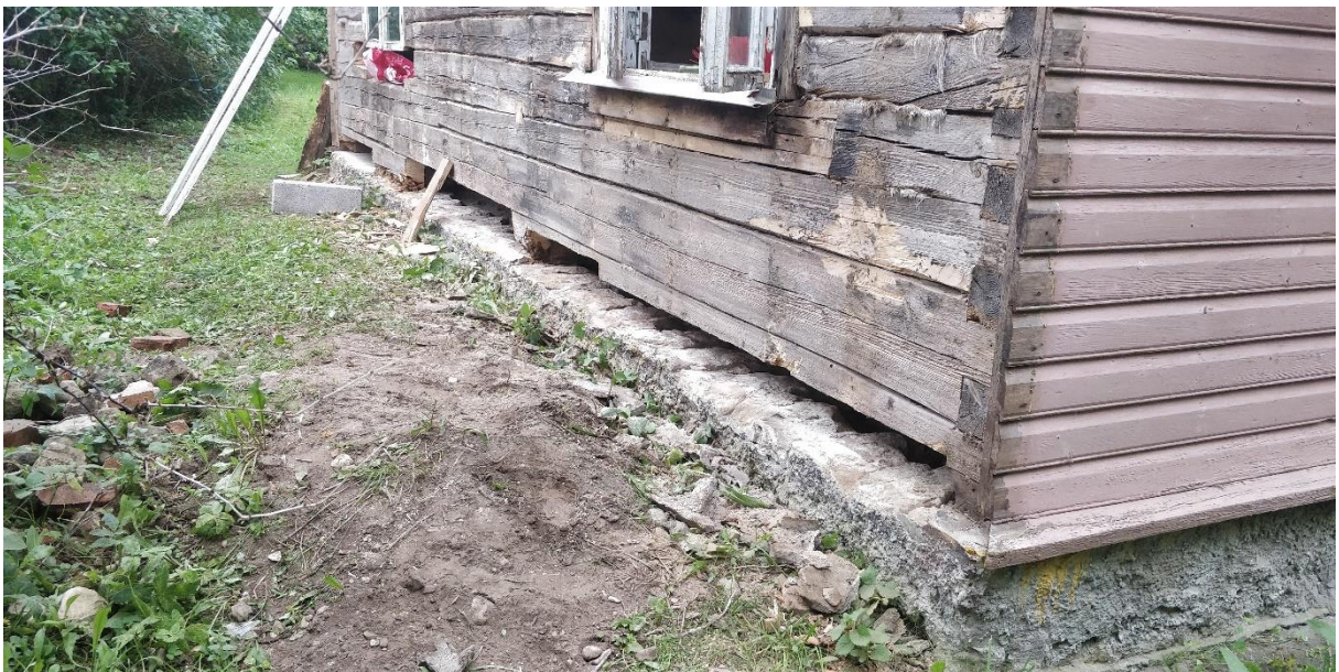
Pilt 10. Vaade paekivist vundamendile lõunaküljelt 08.2021 (allikas: Autor)
