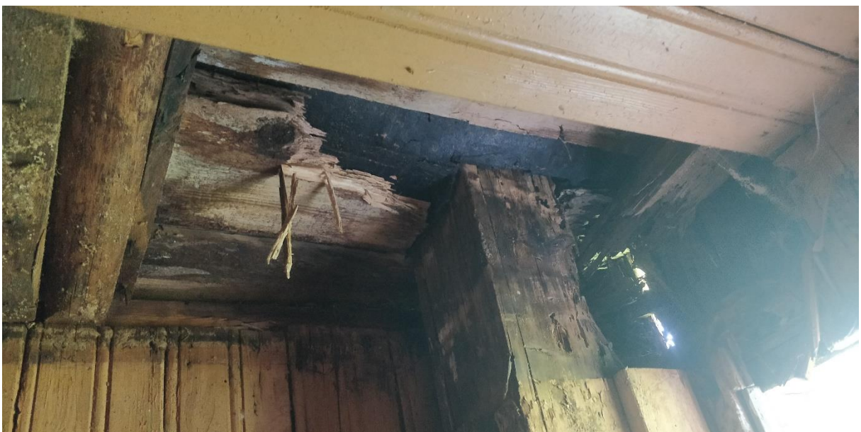
Pilt 33. Vaade eeskoja katuslae ulatuslikule niiskuskahjustusele seest pool 08.2022 (allikas: Autor)
