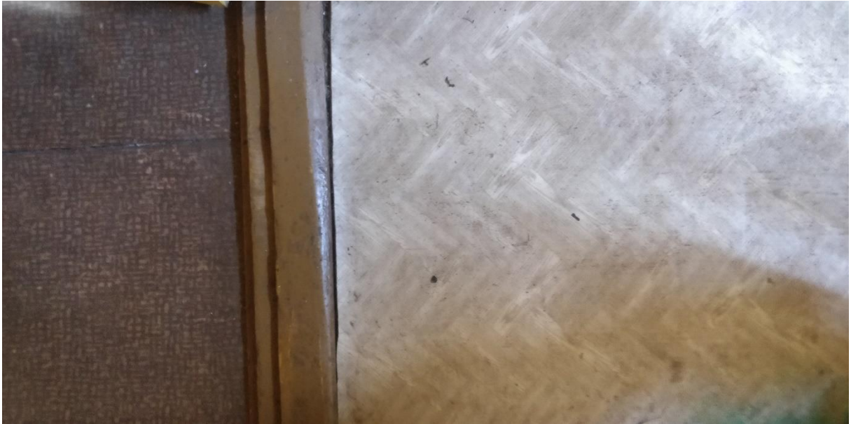
Pilt 14. Erinevat tüüpi linoleum põrandakatted 08.2022 (allikas: Autor)
