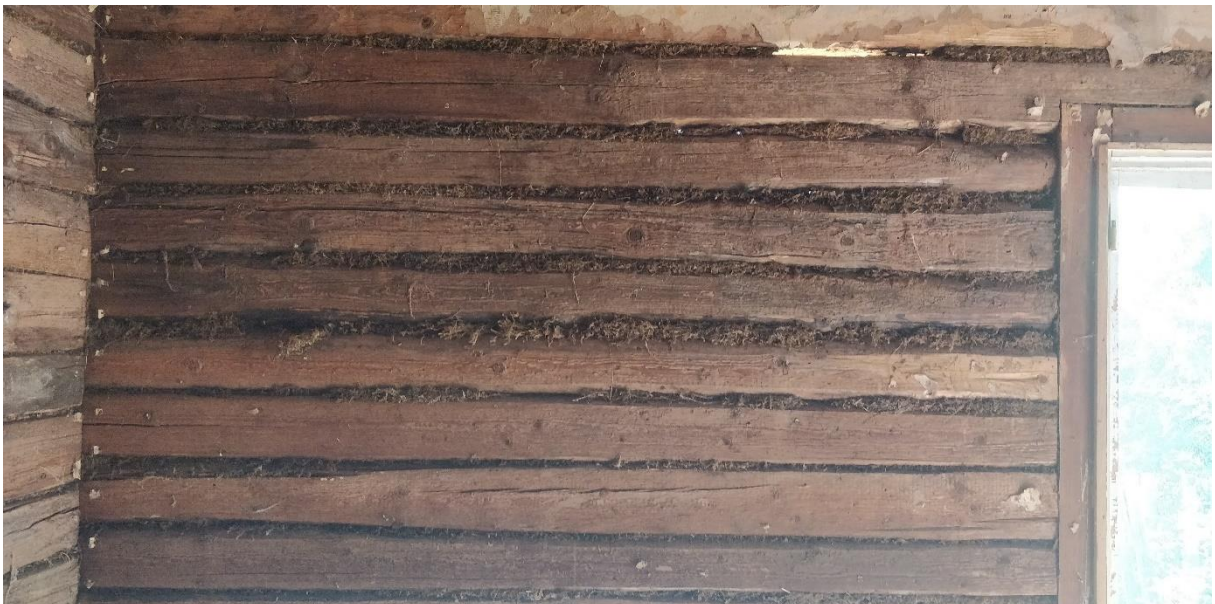
Pilt 23. Vaade välisseinale seest poolt, palkide vahel on näha sammalt 08.2022 (allikas: Autor)
