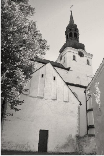
8. Toomkiriku Jüri kabel.
