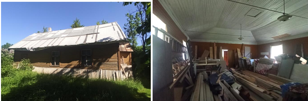
123, 124. Rannamõisa palvemaja välis- ja sisevaade 2022. a juunis. Katus on kaetud kilega läbijooksu peatamiseks. Saali laes, eriti aga abiruumi osas on näha lae tõsist niiskuskahjustust. Foto: autor.
