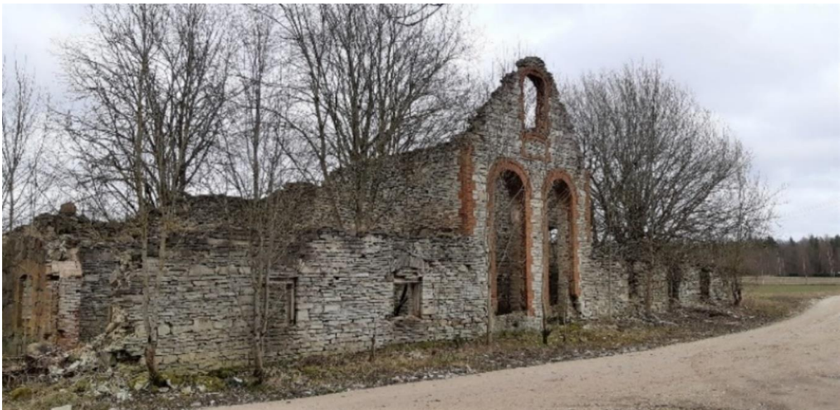
49. Päädeva mõisa viinavabriku 2020.a aprillis. Paekivihoone tellisest nurgaketi ja aknaääristusega. Autori foto.
