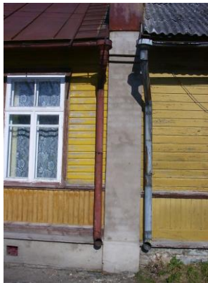
Kenasti hoitud majadel on ka vihmaveetorud tänaseni säilinud (Kalevi tn)
