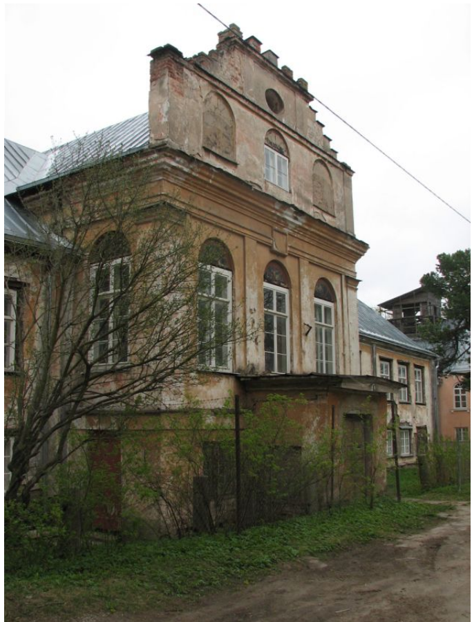
Foto nr. 7 Peafassaadi risaliit ja peasissepääs
