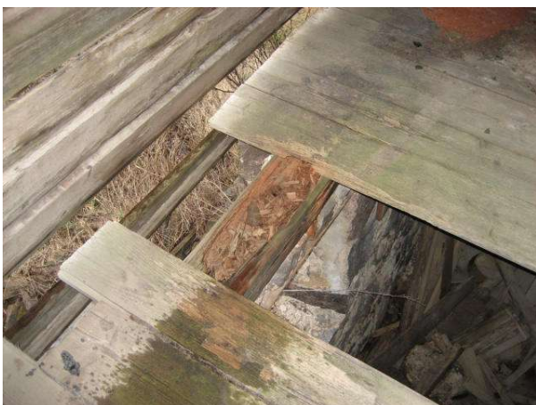
Foto 29 W-i poolne teise korruse horisontaaltala
