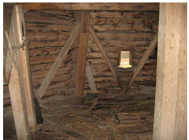
Foto 30 Kolmanda korruse S-i poolne soikude paar
