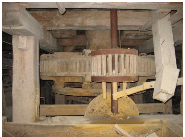
Foto 34 Suurratas, värkel, jahutoru (esimene korrus)
