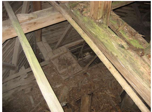
Foto 28 Kolmanda korruse põrand (all)
