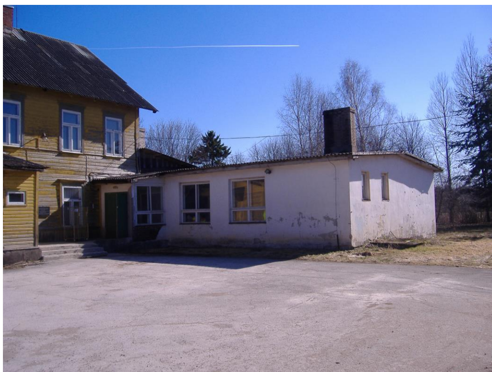
Foto nr 8. Hoovilt vaade juurdeehitusele. Maja esine on asfalteeritud.
