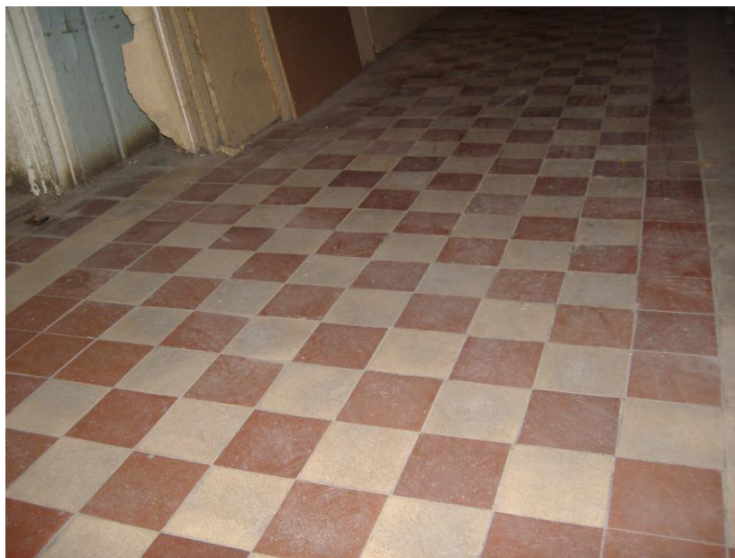
Foto nr 24. I korruse koridori põrand.
