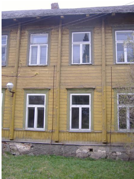
Foto nr 15. Tagaseina on toetatud kolme püstpoolpalgiga
