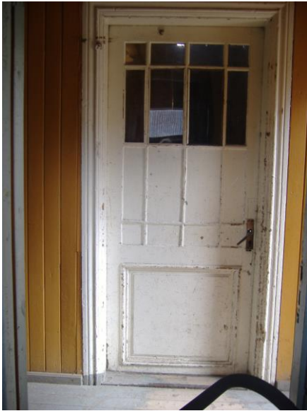
Foto nr 39. I korrusel uks eeskojast koridori
