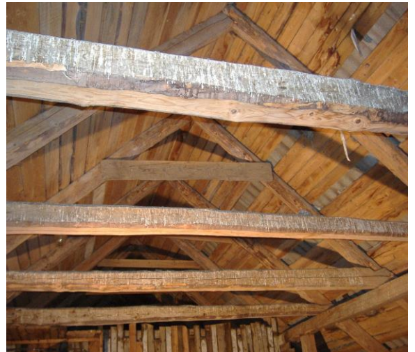
Foto nr 12. Katusekonstruktsioonid.
