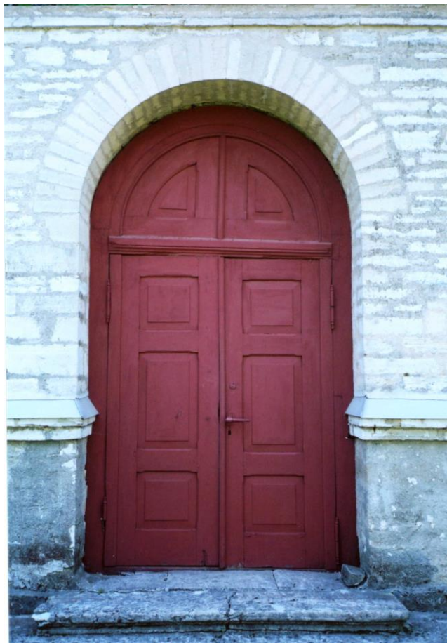
5. Puitused koos käepidemete ja sepiestega kül- ja tagafassaadidel.
