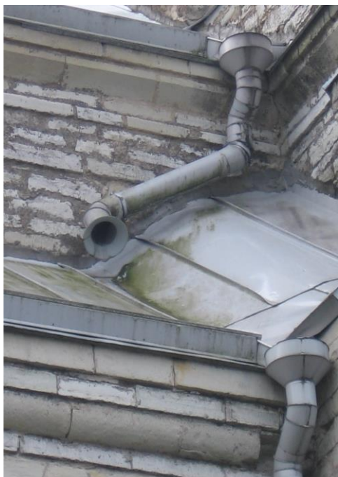
7. Vihmaveetorude otsad ja betoonist vihmaveerennid.
