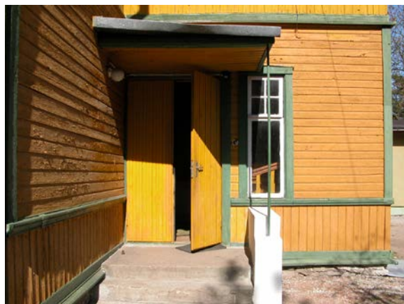
5. Trepikotta viiv parandatud välistreppja uus varikatus
