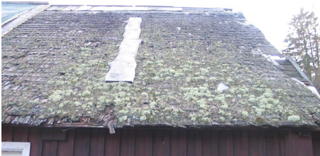
Pilt 13. Põhjapoolne katus on sammaldunud ja vajab välja vahetamist
