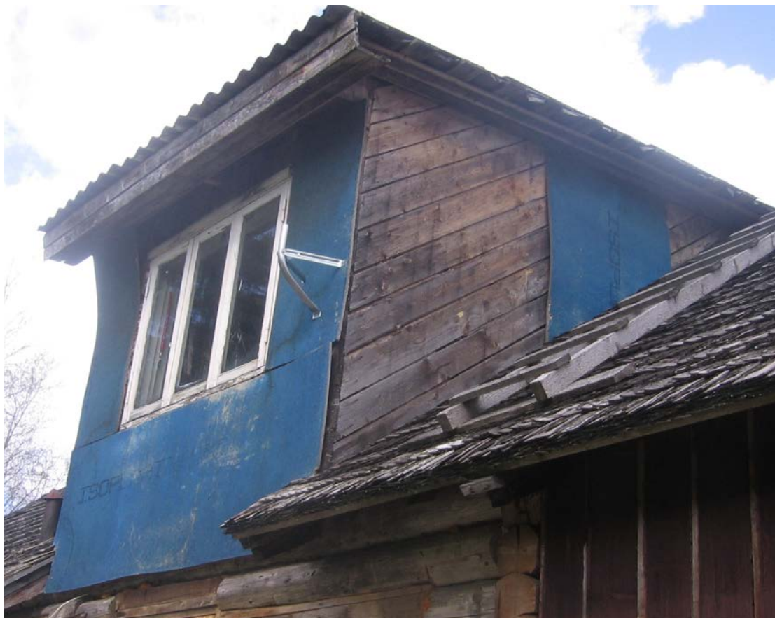
Pilt 14. Vintskapi seinu tuulekindlamaks muutmiseks eemaldati välisvooder, paigaldati tuuletõkkeplaadid ja töö jäi lõpetamata.
