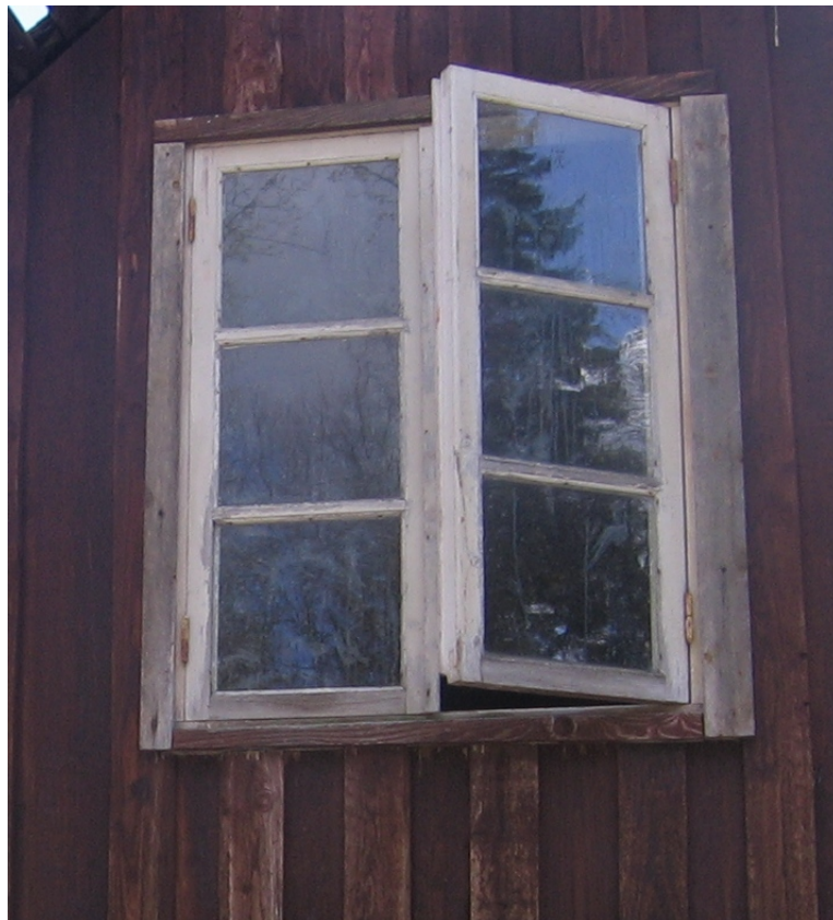
Pilt 10. 1990ndatel tehtud uus aknaava maja metsapoolses otsaseinas. 1974. aasta remondi käigus paigaldatud aken, mis 1980ndate remondi käigus välja vahetati.
