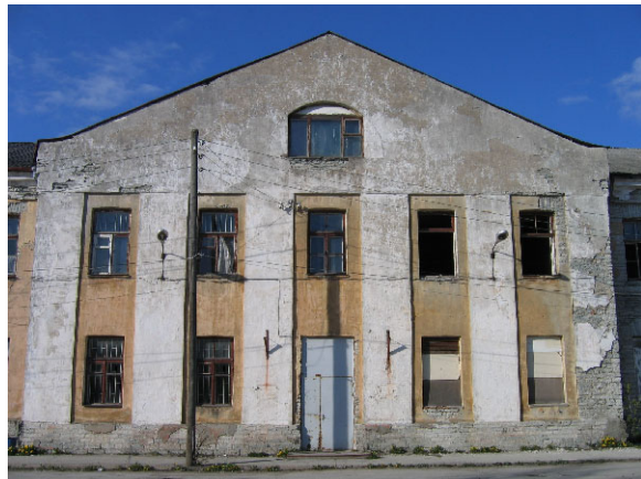
3. Keskrisaliit osaliselt kinniehitatud veneetsia aknaga
