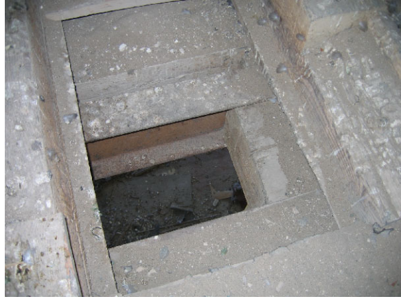
13. Läbi augu paistavad vahelage toestavad lisapalgid ja raudlatid
