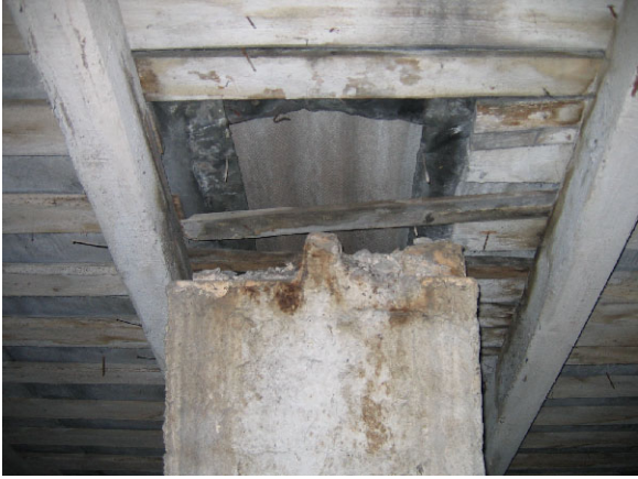
12. Lammutatud korstnaots. Augu kohalt võib näha mõlemat katusekattematerjali
