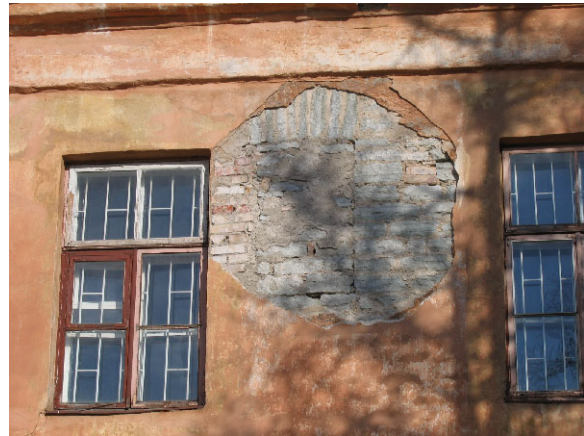
15. Krohvivaringu alt avaneb kinnimüüritud aken läänetiiva otsaseinas
