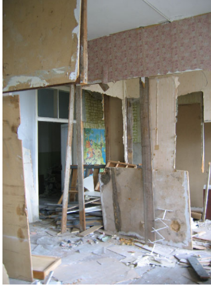
9. Pooleldi lammutatud hilisemad vaheseinad
