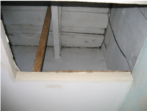
14. Ripplae kohal paistavad vahelae toetuslatid
