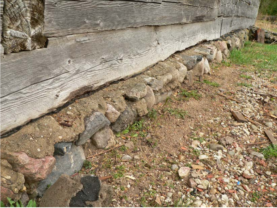
Foto 6.21. Vaade vundamendile läänesuunalt
