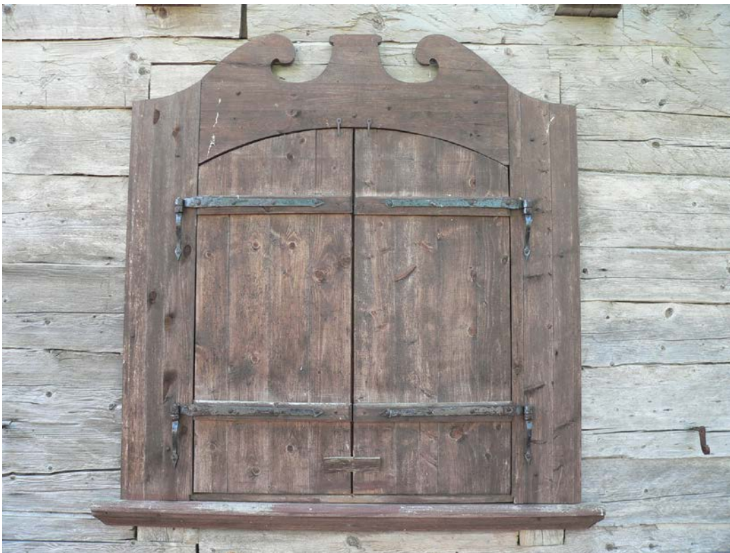
Foto 6.15. Viimaste restaureerimistööde käigus valmistatud aknaluugid ja raamistik
