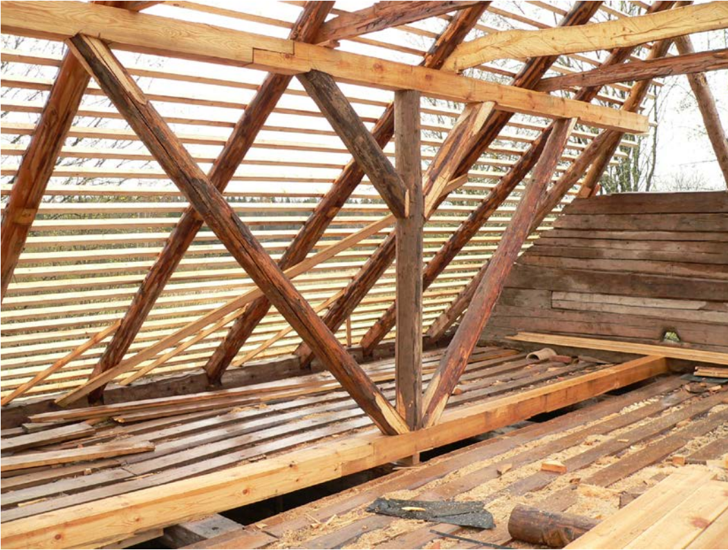
Foto 6.9. Toolvärk vastavalt projektile on ehitatud toetuma kandeseintele.
