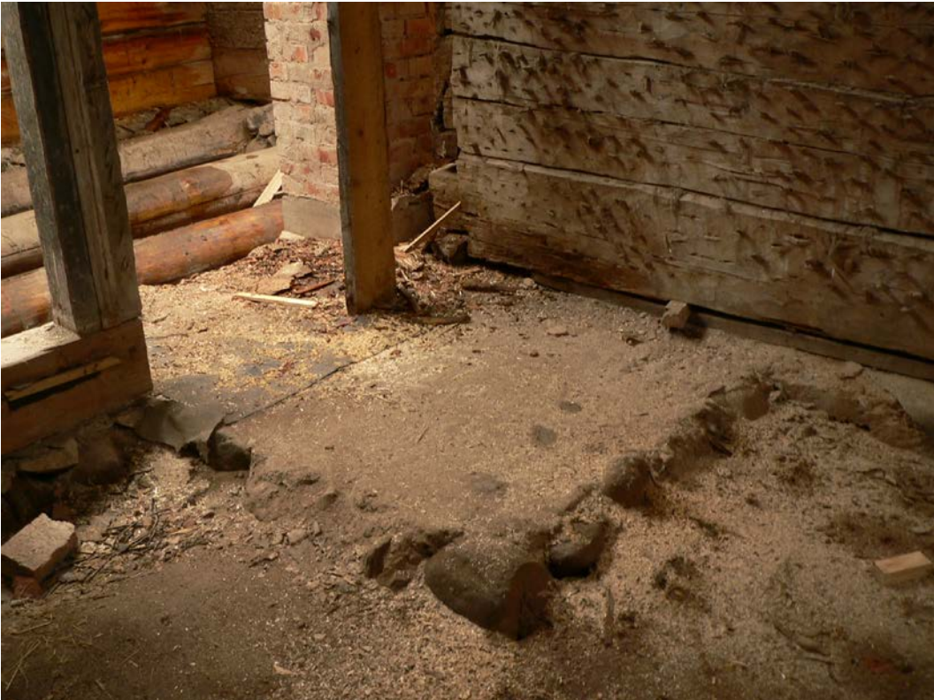
Foto 6.18. Ahju vundament hoone lõunaküljel
