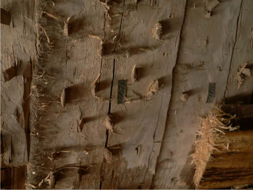
Foto 6.17. Tikutatud sisesein märgitatud lipikutega
