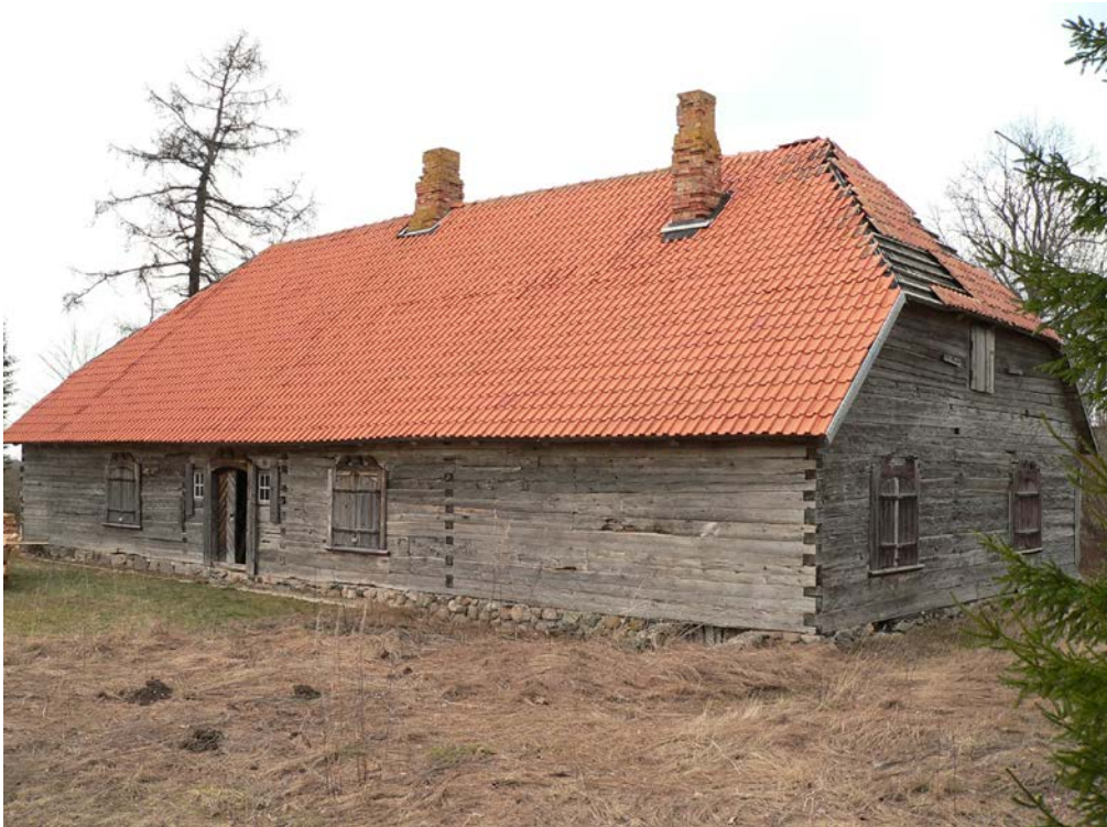
Foto 6.1. Olukord enne katusetööde alustamist, vaade hoone tagumiselt küljelt.
