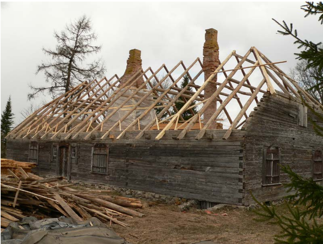
Foto 6.7. Sarikad vahetatud, proteesitud ja tagasi peale tõstetud
