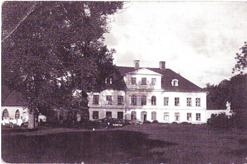
Mõisa peahoone esifassaad 1950.
