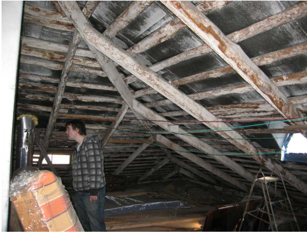
Foto 35. Hoovihoone katusekonstruktsioon. Foto: Erja-Liina Raidma 2008.
