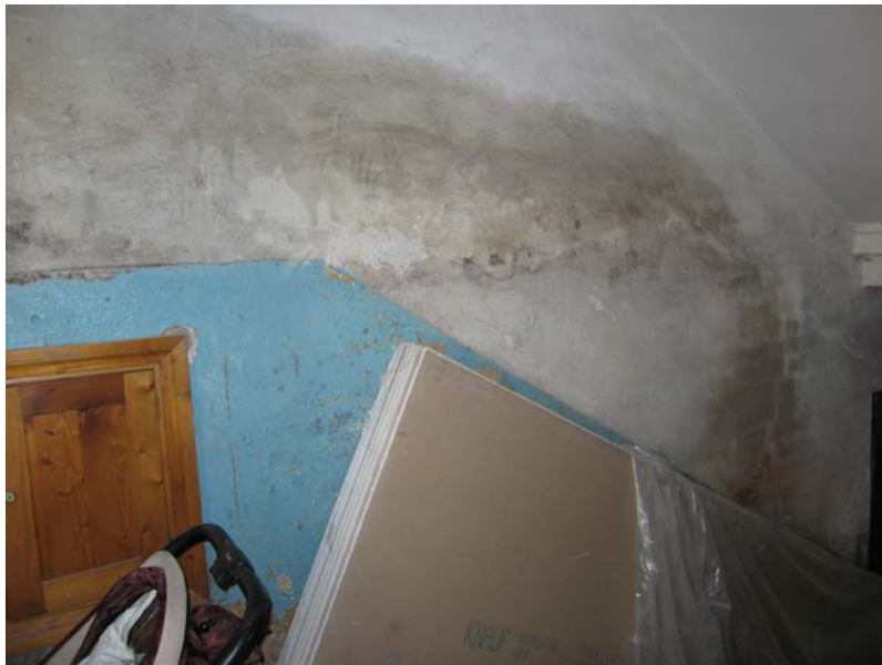
Foto 45. Trepikoja seina niiskuskajustused. Foto: Erja-Liina Raidma 2008.
