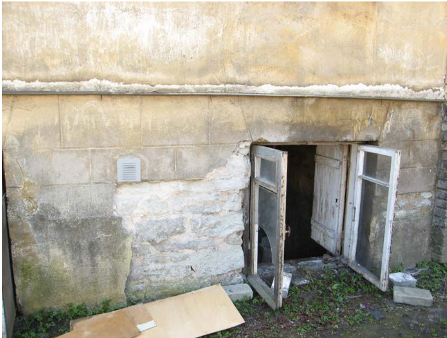
Foto 31. Hoone esifassaadil on sokkel kaetud rustikaimitatsiooniga dekoratiivse krohvigiga. Foto: Erja-Liina Raidma 2008.
