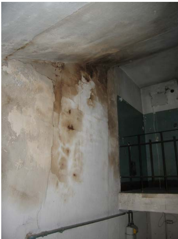
Foto 40. Ulatuslik pigilaik trepikoja pööningukorrusel. Foto: Erja-Liina Raidma 2008.
