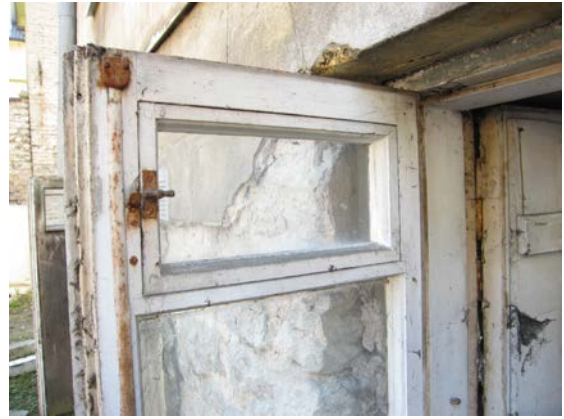
Fotod 41, 42. Keldriakende säilinud kremoonid ja sulused. Foto: Erja-Liina Raidma 2008.
