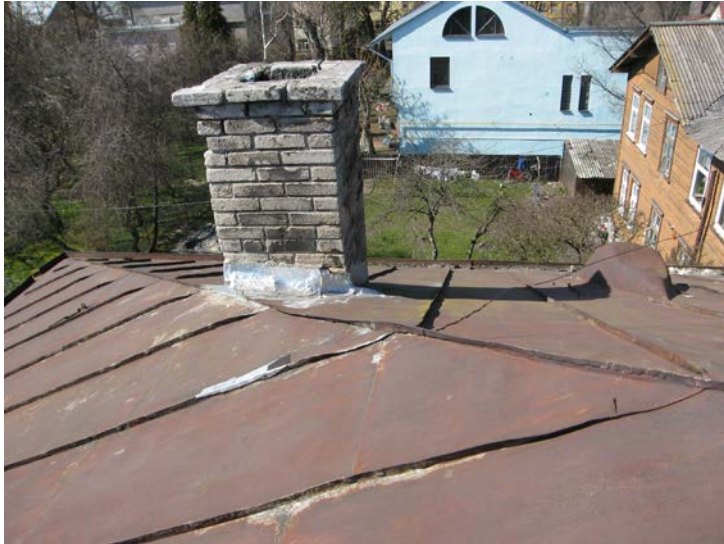
Foto 10. Tööstuse 9 hoovihoone algupärane tsinkplekk-katusekate, korstnapits ja kaarjas katuseaken. Foto: Erja-Liina Raidma 2008.
