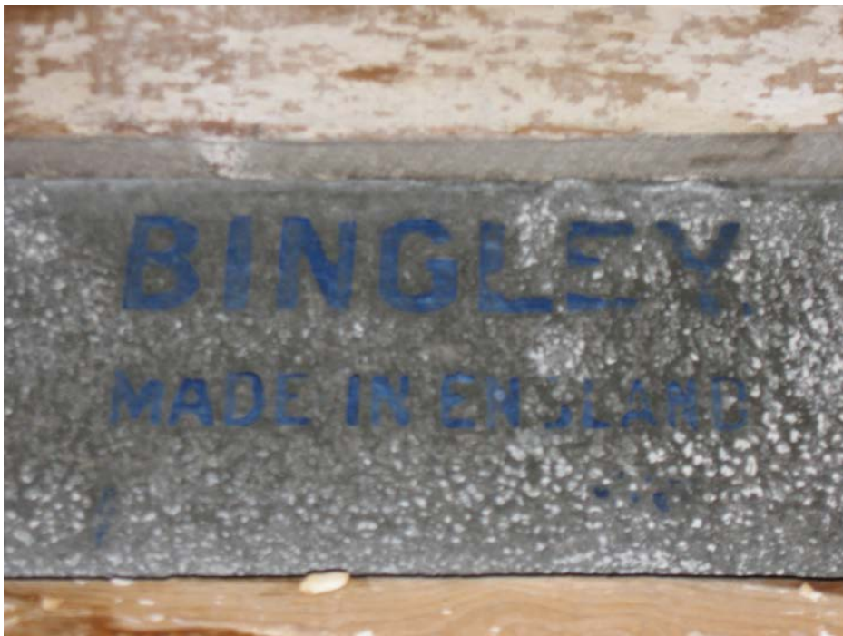
Foto 36. Hoovihoone ehitusaegse tsinkplekk-katuse märgistus. Foto: Erja-Liina Raidma 2008.
