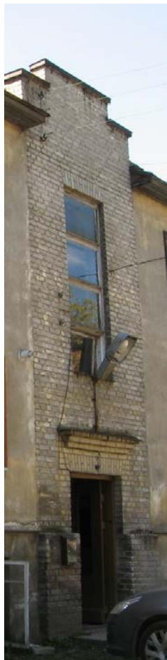
Foto 11. Tööstuse 9 hoovihoone astmikviiluga silikaattellistest trepikoda. Foto: Erja-Liina Raidma 2008.
