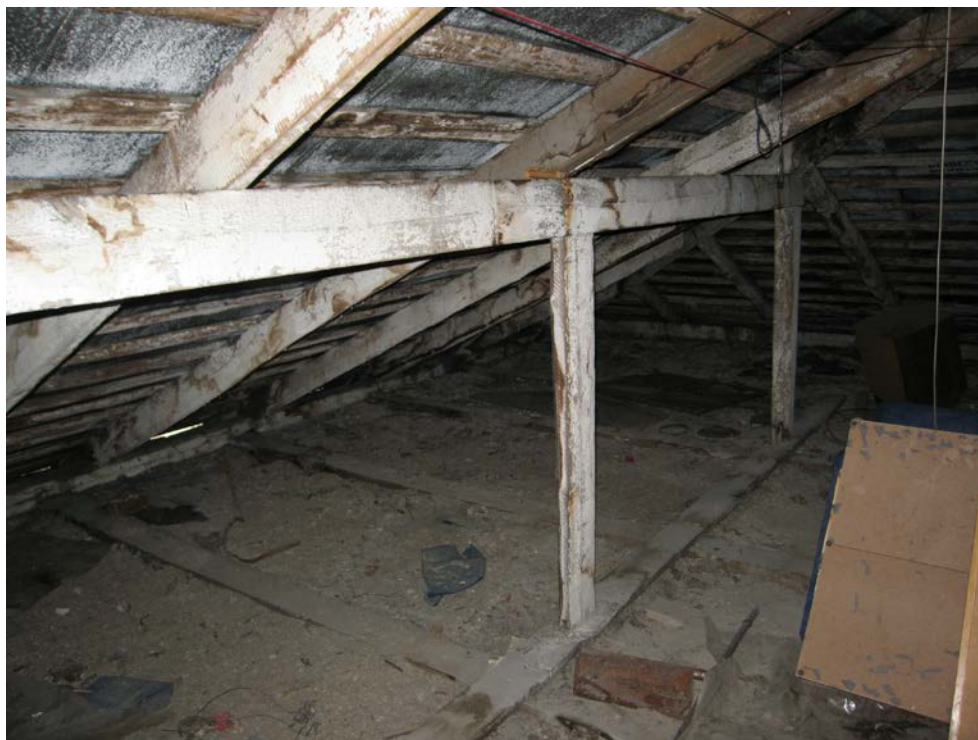
Foto 34. Hoovihoone katusekonstruktsioon. Foto: Erja-Liina Raidma 2008.
