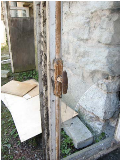
Fotod 41, 42. Keldriakende säilinud kremoonid ja sulused. Foto: Erja-Liina Raidma 2008.
