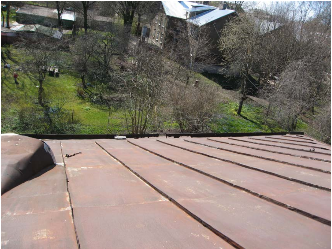
Foto 37. Hoovihoone pitsiliseks roostetanud katusepealsed vihmaveerennid. Foto: Erja-Liina Raidma 2008.
