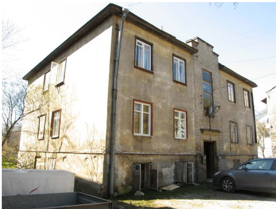
Foto 17. Tööstuse 9 hoovihoone põhja- ja idafassaadi vaade . Foto: Erja-Liina Raidma 2008.
