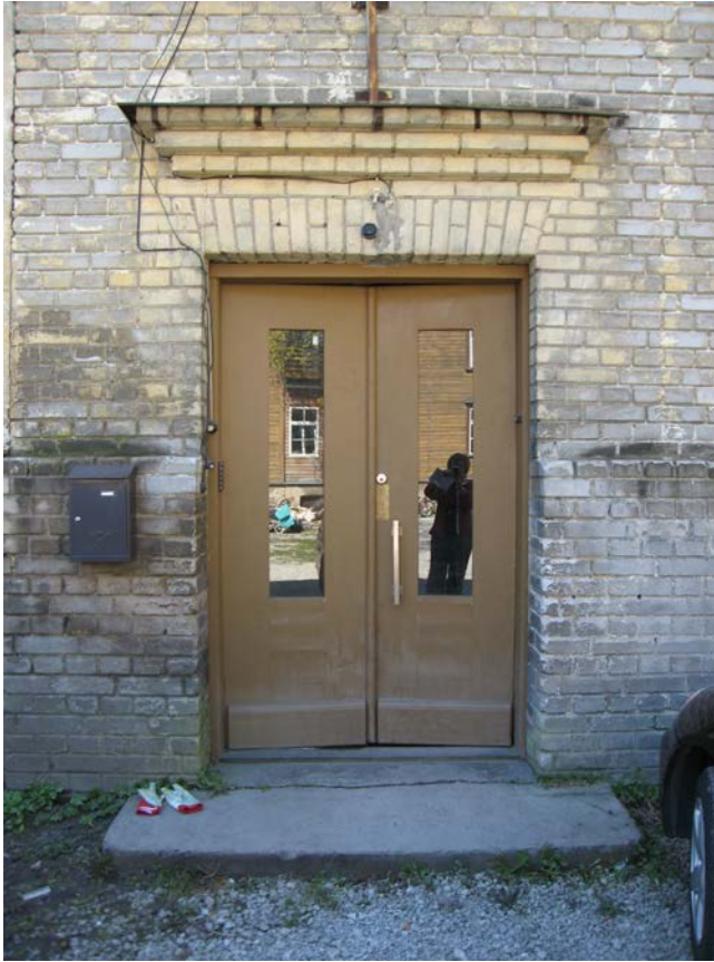
Foto 13. Tööstuse 9 hoovihoone algupärane välisuks koos varikatuse ja trepimademega. Foto: Erja-Liina Raidma 2008.
