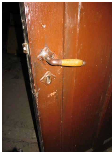
Fotod 29, 30. Hoovihoone keldri ja pööningu profileeritud tahveluksed koos käepidemetega. Foto: Erja-Liina Raidma 2008.
