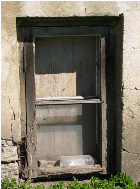
Foto 43. Hoovipoolse fassaadi niiskus- ja päikesekahjustustega keldriaken. Foto: Erja-Liina Raidma 2008.
