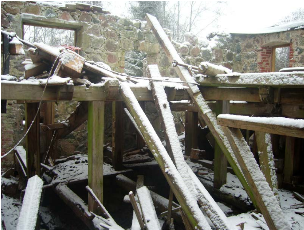
Foto nr. 9 Vahekorruse puitkonstruktsioon
