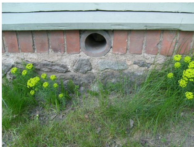
Joonis 3.1. Vundamendi sokliosaga koos tellistest vööga
