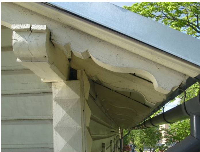
Joonis 2.6. Katusekonstruktsiooni ilmestavad a) soonitud nurgalaudadega vintskapp; b) katuseharjal olevad figuraalsed puidust postid; c) seinast väljaulatuv toolvärgi ülemise tala konsool koos figuraalsete sarikaotstega; d) katuseharja posti alumine ots
