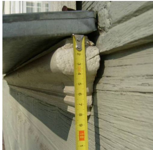
Joonis 2.5. Akende detailid a) esifassaadi akende piirdelaudade alanurk; b) veepleki toetuspruss
