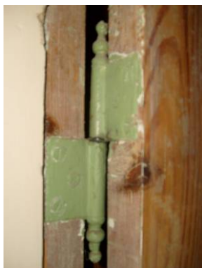
Joonis 3.4. Avade detailid. a) ukse käepide; b) uksehing; c) aknakremoon
