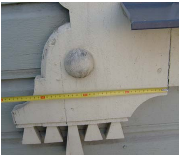
Joonis 2.5. Akende detailid a) esifassaadi akende piirdelaudade alanurk; b) veepleki toetuspruss
