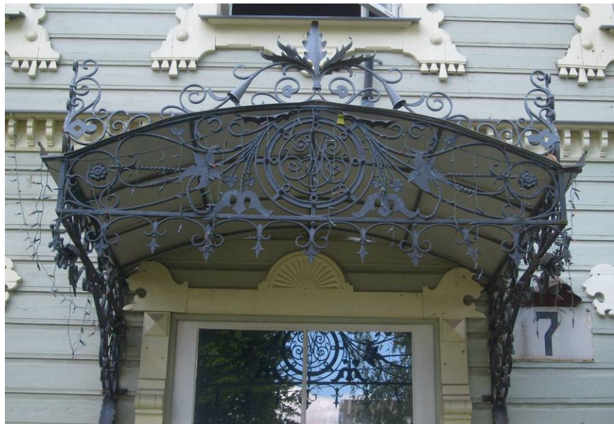
Joonis 2.7. Hoone fassaadi ilmestab välisukse varikatuse sepistatud ornamentika (nimetähed MP tähistavad maja esimest omanikku ja ehitajat puidutööstur Mihkel Pärni).
