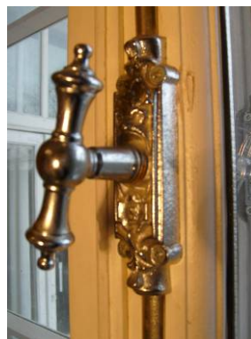
Joonis 3.4. Avade detailid. a) ukse käepide; b) uksehing; c) aknakremoon
