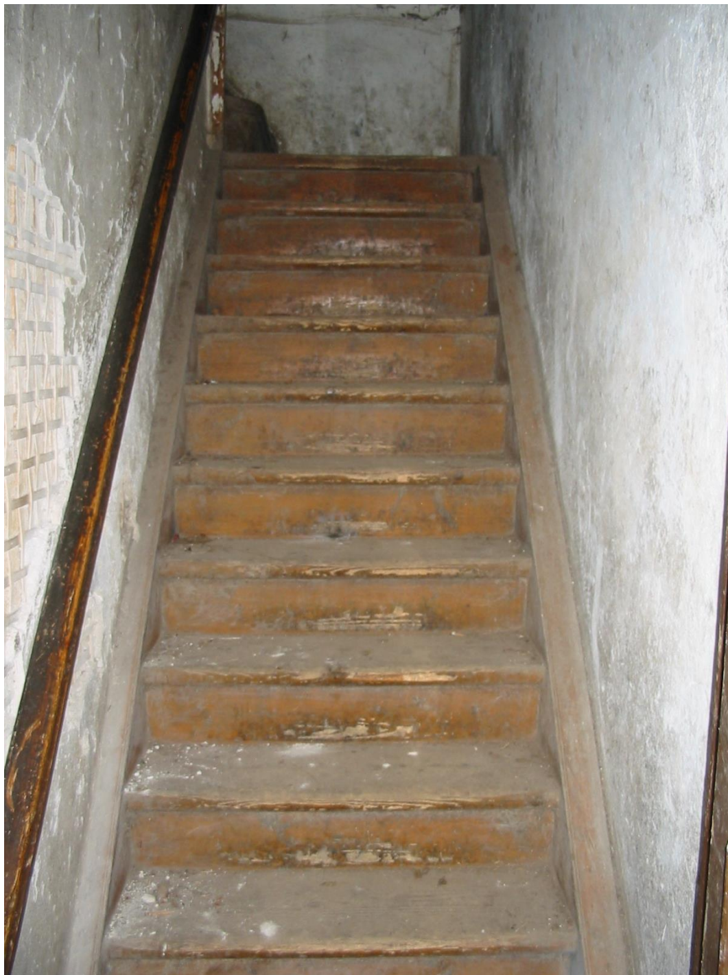
Foto nr 38 – Puittrepp.
