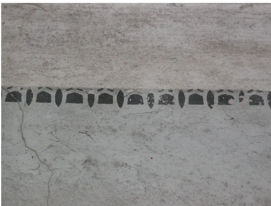
Foto nr 17 – Seina trafarettmaaling ruumis 12 (seina ülaosas).
