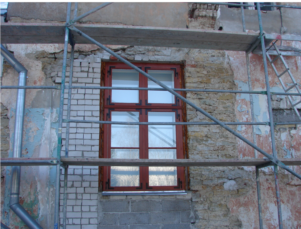
Foto 24. 2008. a kevadeks on renoveerimistöodega jõutud ka välisfassaadini. Fotol mõisa tagafassaad nagu see jäi 2002. a, selgelt on näha ehitusfirma Remet arusaamu sobivate materjalide kasutamisest. Kristjan Lutsu foto.
