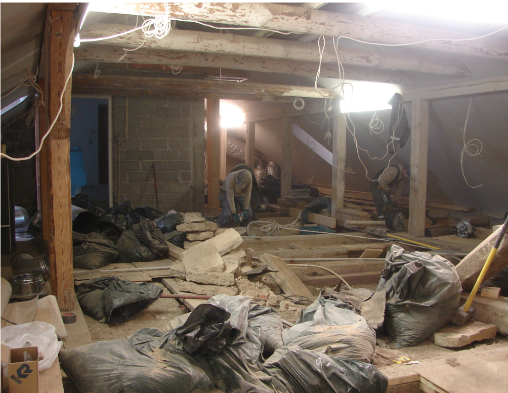
Foto 22. Siingi on näha Fibro plokkidest laotud sein ja kipsplaadi kasutamist siseviimistluses. Kristjan Lutsu foto.
