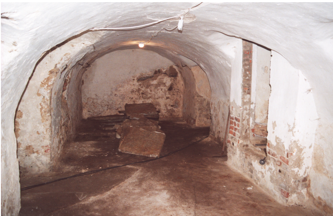
Foto 16. Mõisahoone keldri seinad ja völvlaed olid Nõukogude perioodil kaetud krohviga. 2002. a renoveerimise käigus eemaldati krohvikihht ning täna on eksponeeritud pækivi oma täies hiilguses. Tiina Tojaku foto.
