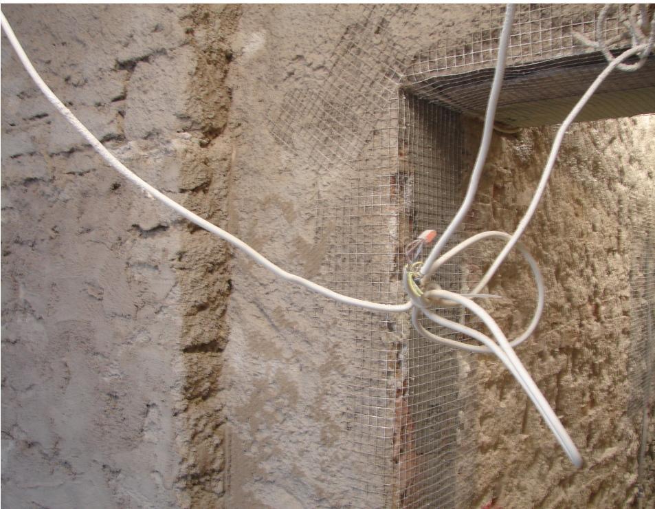
Foto 20. Tulevane fondihoidla peahoone parempoolses tiivas. Seinad puhastati kuni paekivini, seejärel kaeti masinkrohviga. Kristjan Lutsu foto.
