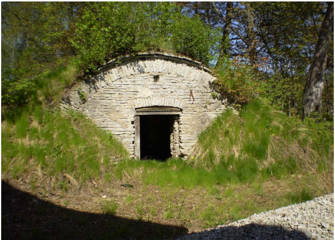
Foto nr.15 Vaade jääkeldrile kagust 2008a.
