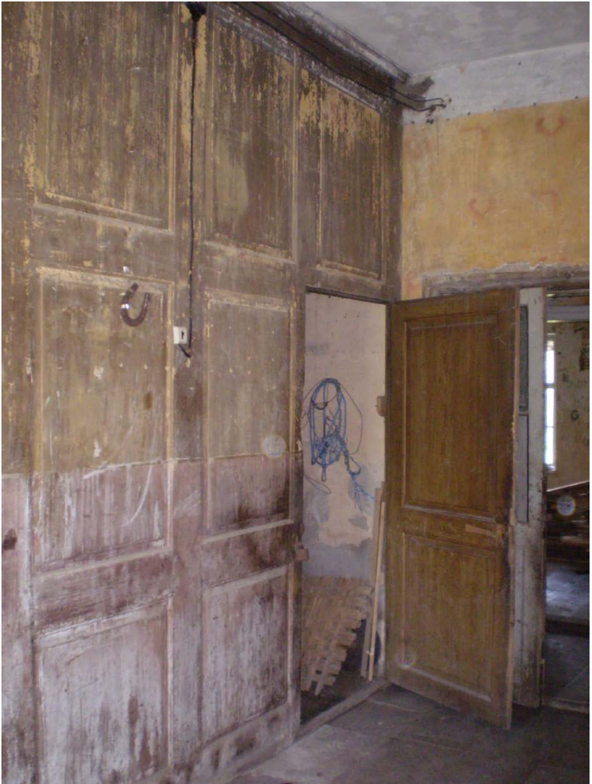
Foto nr.53 Aaderdatud paneelid härrastemaja vestibüülis. Paneeli katnud lubivärv on viimistluskihti oluliselt kahjustanud.2008.a.
