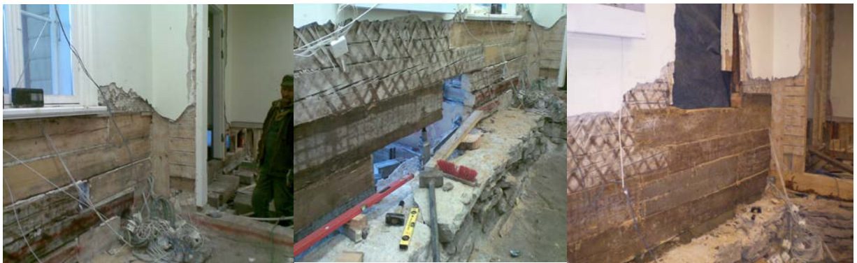
Foto nr.57 Sein enne parandamist, plommimise ajal ja plommitud sein. Seina ei ole plommimise ajal tõstetud.
