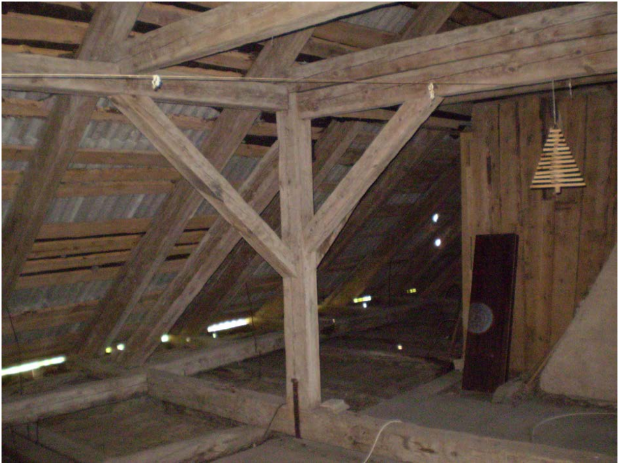
Foto nr.37 Trapetsturvikkatuse sõlm, ripp-post, kammitspenn, tugikäpp, sõlgpuu, pärlin.
