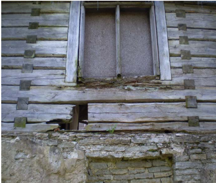
Foto nr.33 Palgikahjustused tiibhoone kirdeküljel 2008.a.
