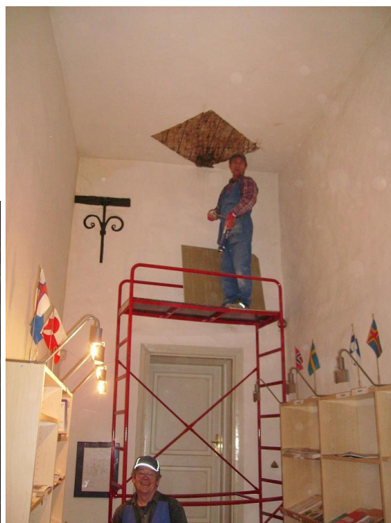
Pilt 12 Mahavarisenud krohvi asendustööd
