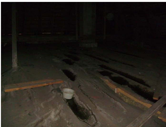
Pilt 16 Pööningu vahelaele paigaldatud kile
