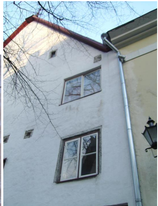
Pilt 19 Esifassaadi sobimatu III korruse aken
