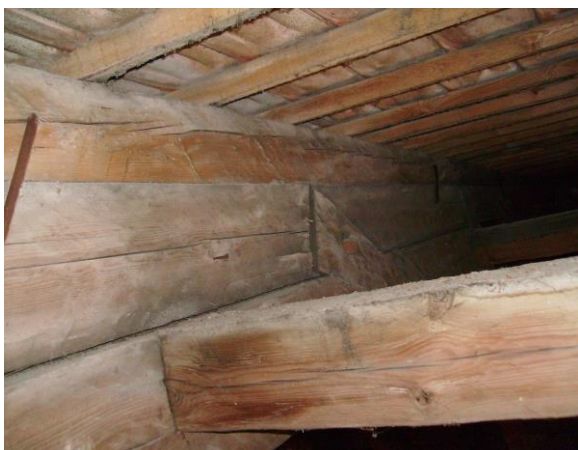
Pilt 14 Esialgne rihitud katusesarikas. Uus rihtpruss on kinnitatud riiskadega.
