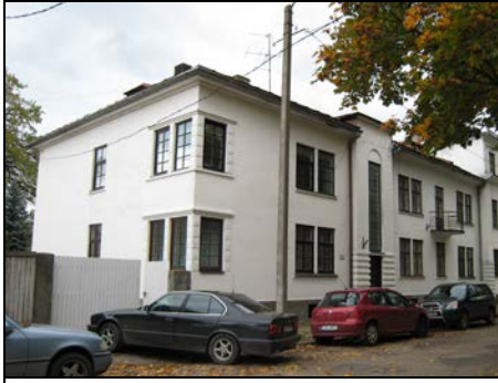
Jalaka tn 2 (1930.a)
