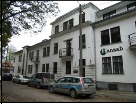
Jalaka tn 4 (1930.a)
