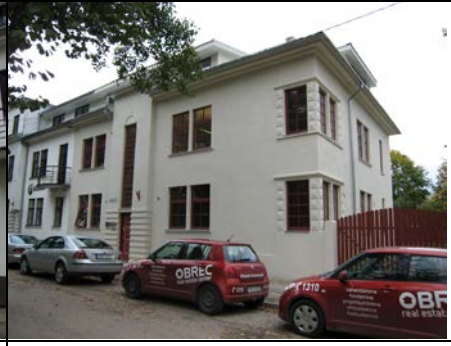
Jalaka tn 6 (1930.a)
