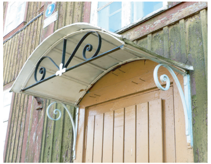
Foto 31: Varikatus esifassaadil, originaal (autori foto 2008)
