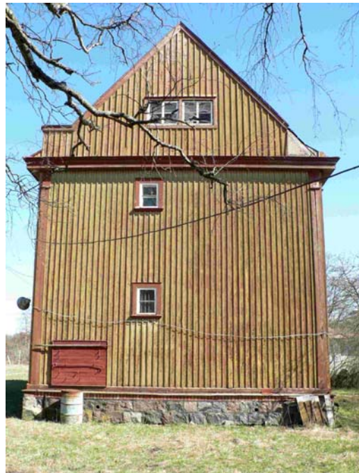
Foto 13: läänefassaad, puudu parapetjas aste otsaviilul (autori foto)
