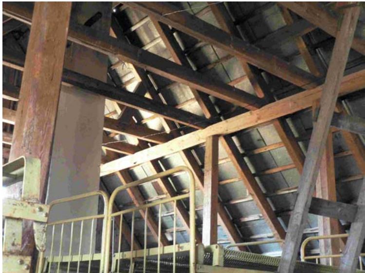
Foto 14: Katusekonstruktsioon (autoti foto)
