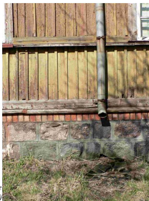
Foto 12: Vihmaveetoru liiga kõrgel, horisontaalne fassaadiliigendus hilisem ümberehitus (autori foto)
