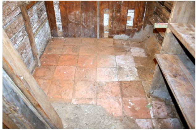
Hoone vanemas osas paljastus hilisema laudpõranda alt põletatud saviplaatidest põrand. Fotod 2008
