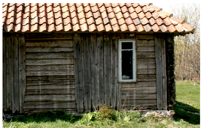
Hoone lõunakülj pärast laudvoodri eemaldamist 2008.aastal. Kohati on näha tugevad kahjustused. Pinnas on tõusnud alumise palgireani (vasakul). Sahrvi välisseinal paljastus vana püstlaudis (paremal). Fotod 2008-2009
