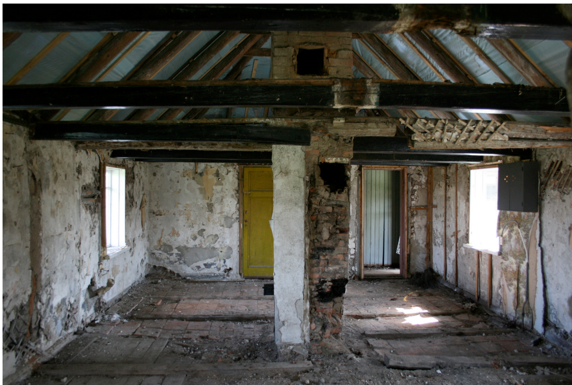
Sisevaade pärast kipsplaadi ning hilisemate põrandakihtide eemaldamist. Algselt on kogu hoone I ehitusjärgu põrandaid katnud põletatud savitellisplaadid ning seinu katnud lubikrohv. Vahelaed on avatud. Näha on kahjustatud vahelaetalad. Foto 2009
