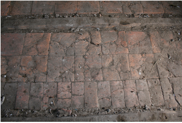
Hoone vanemas osas paljastus hilisema laudpõranda alt põletatud saviplaatidest põrand. Fotod 2008
