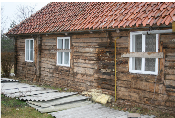
Hoone lõunakülj pärast laudvoodri eemaldamist 2008.aastal. Kohati on näha tugevad kahjustused. Pinnas on tõusnud alumise palgireani (vasakul). Sahrvi välisseinal paljastus vana püstlaudis (paremal). Fotod 2008-2009
