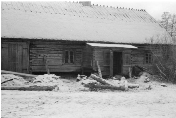
Hoonele ehitati raudkividest vundament ja vahetati alumised palgid 1959.aastal. (Foto Joann Kallas 1959.a)
