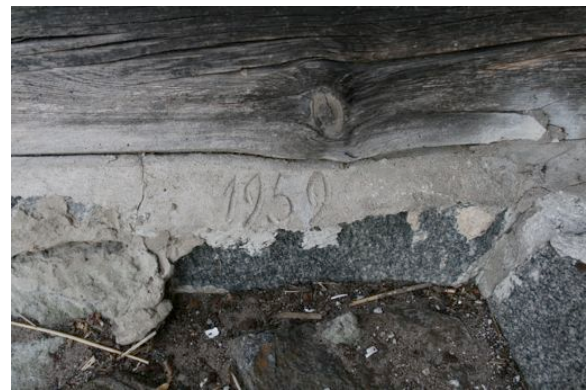
Hoonele ehitati raudkividest vundament ja vahetati alumised palgid 1959.aastal. (Foto Joann Kallas 1959.a)
