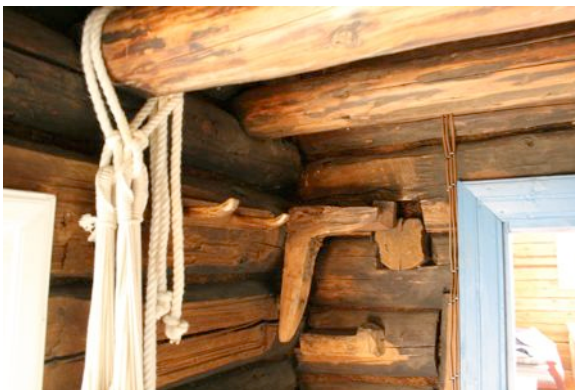
Rehetoa säilinud konstruktsioonid (Foto 2009)
