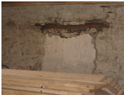
Foto 15 Kinnimüüritud väikeaken lääne otsaseinas
