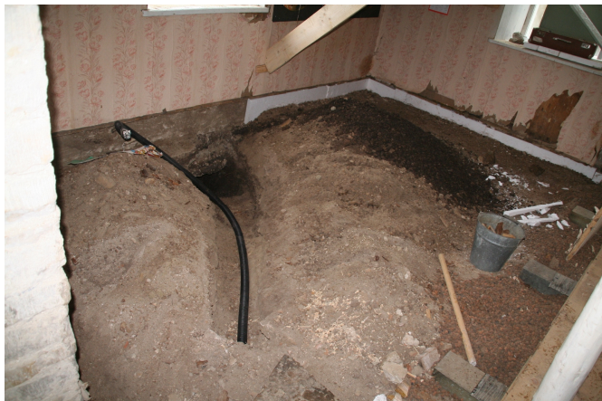
Foto 70 Veetoru sisse toomine
