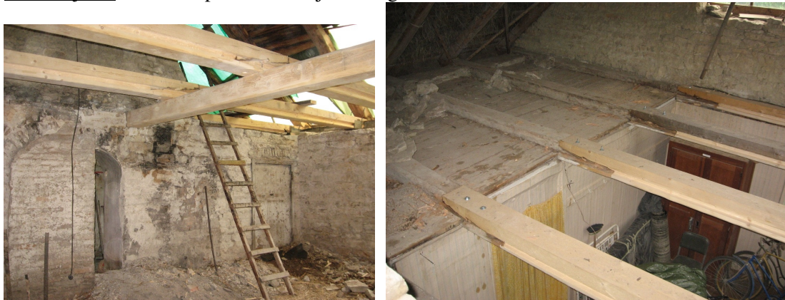
Fotod 4 ja 44 Sarikate plommimine ja taladega sidumine. Uus müürilatt.
