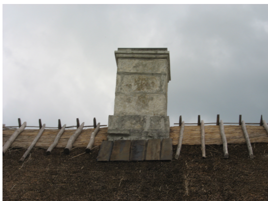
Foto 49 Harimalgad ja paigaldatud laudis
