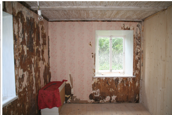
Foto 20 Seinalaudis ja vana lagi eemaldatud lubivärviga
