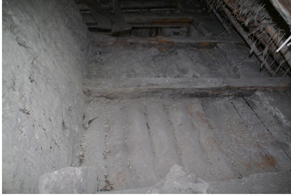
Fotod 39 ja 40 Soojtusest puhastatud vanad põrandalauad idapoolse pööningul
