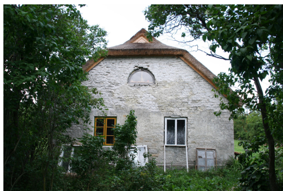
Foto 42 Restaureerimistöde illustratsioon – maja idapoolses otsaseinas näha paigaldatud uus aken, eesolev aken 1970ndatest aastatest, maja seina ääres olev pööningult leitud vana aknaraam.
