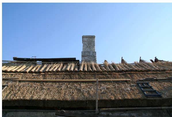
Foto 48 Rookatte paigaldamine
