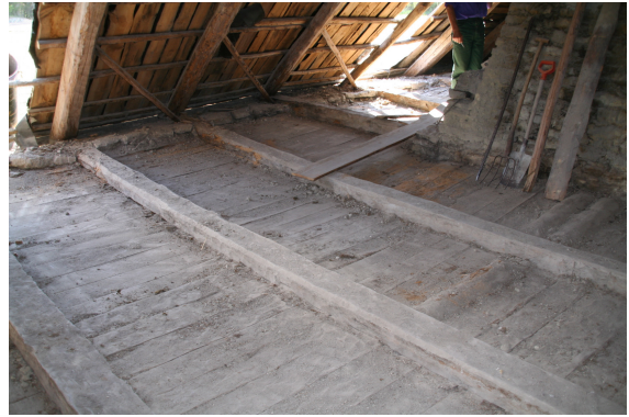
Fotod 39 ja 40 Soojtusest puhastatud vanad põrandalauad idapoolse pööningul
