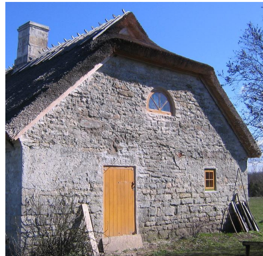
Foto 65 Taastatud otsauks ja väikeaken lääneseinas
