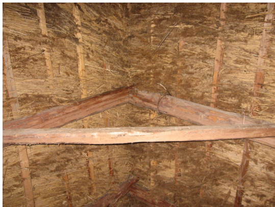
Foto 47 Vaade katuse uue alla, pajuvitstele
