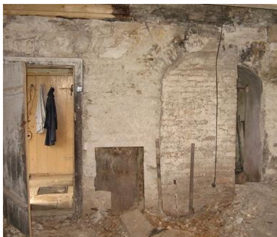
Foto 8 Mantelkorstna kaarava läänepool I korrusel, avatud ehituse käigus
