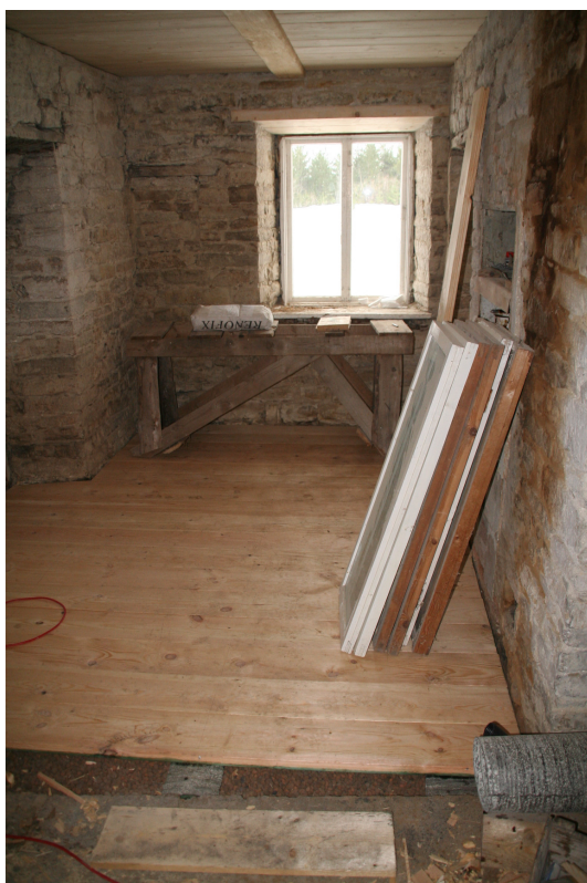
Foto 69 Põrandate tegemine köögis. Paremal näha soemüüri osa väljalõhkumisest tekkinud seinarv vana riuliga ja eksponeeritav paekivisein.
