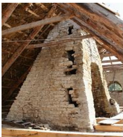
Foto 53 Metalllõõride paigaldamiseks avatud lõõrid mantelkorstna seintes
