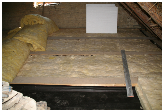
Foto 68 Pööningu põranda soojustamine
