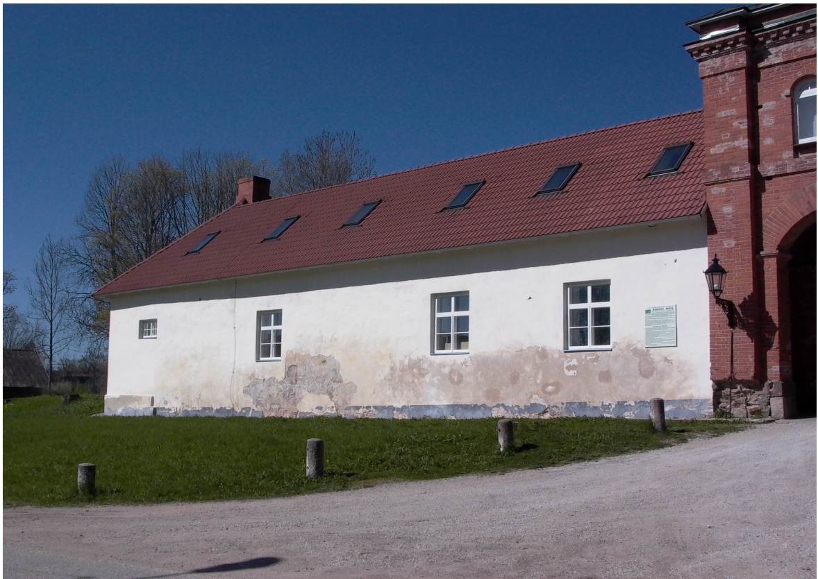
Joonis 24 Väravatorni vasakpoolse hooneosa soola- ja niiskuskahjustustega fassaad mõisa välisküljel. Foto aastast 2005
