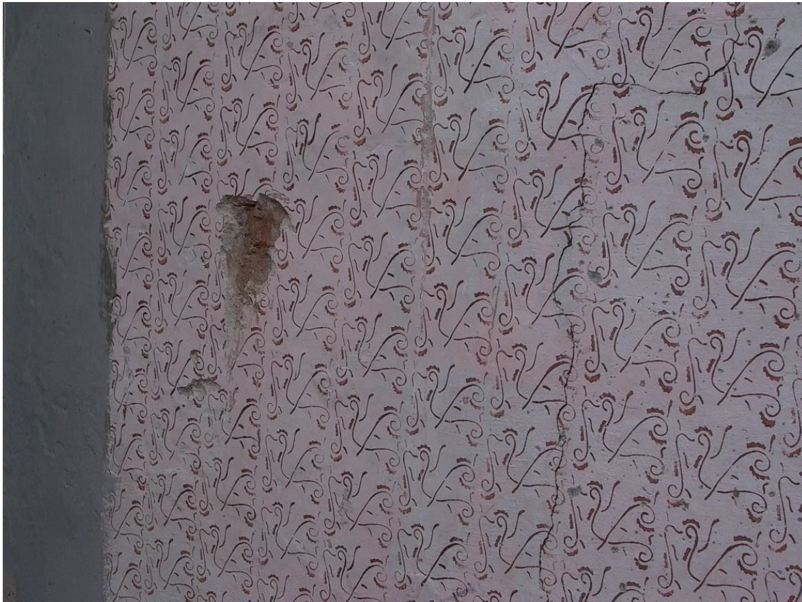
Joonis 33 Parempoolse tiibhoone säilitatav muustrulliga tehtud seinadekoor
