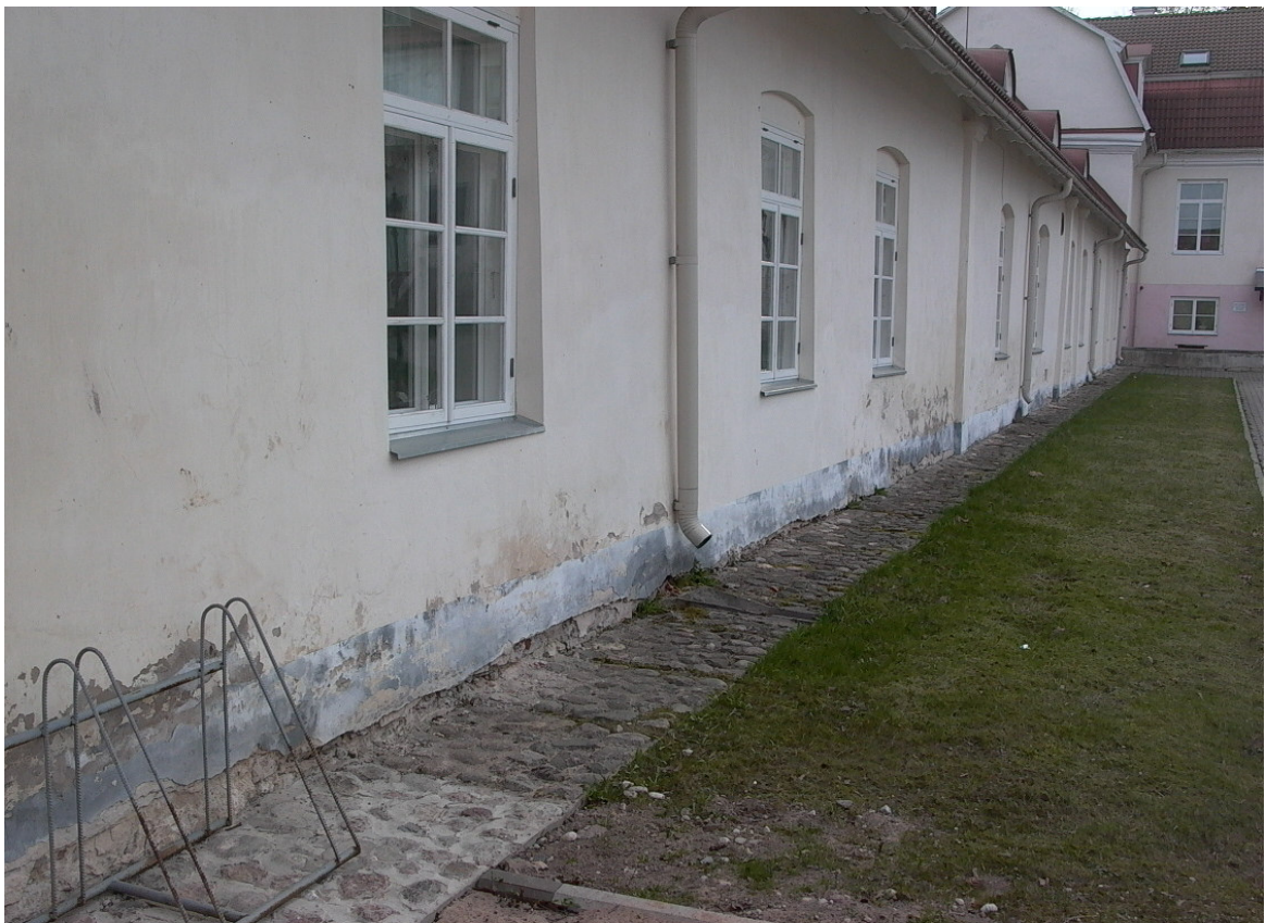
Joonis 19 Vasakpoolse tiibhoone niiskuskahjustustega sokkel vaadatuna hoovi poolt
