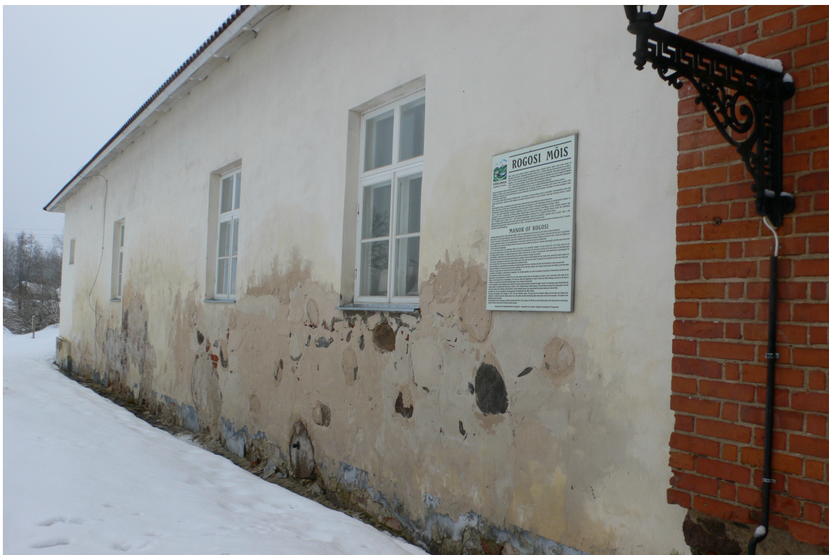
Joonis 39 Väravatorni paremapoolse hooneosa fassaad talvel
