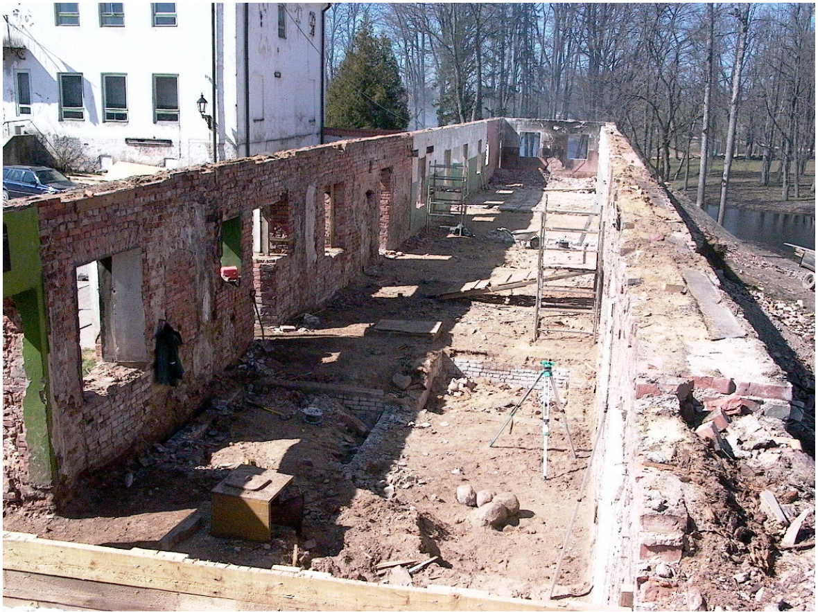
Joonis 30 Parempoolse tiibhoone kandeseinad pärast katusekonstruktsiooni lammutamist
