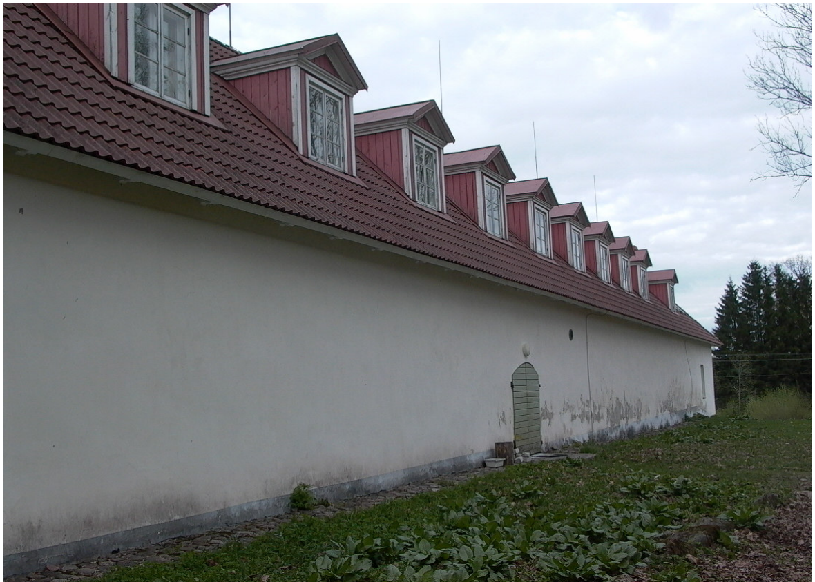
Joonis 17 Vaade vasakpoolse tiibhoone välisküljele edelast
