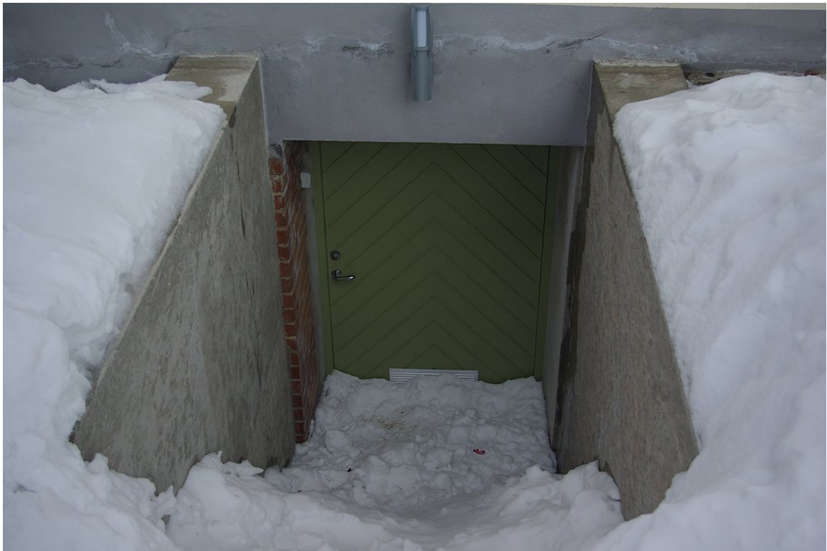
Joonis 35 Parempoolse tiibhoone keldri välisuks
