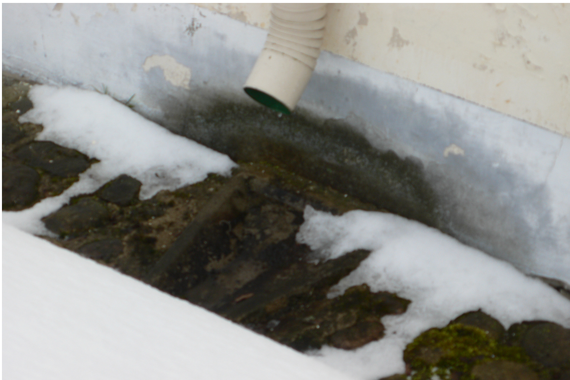
Joonis 38 Vihmaveetoru on voolupüüdjast paigaldatud lubatust kõrgemale
