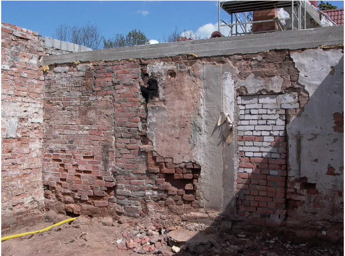
Joonis 31 Parempoolse tiibhoone kandev sisesein
