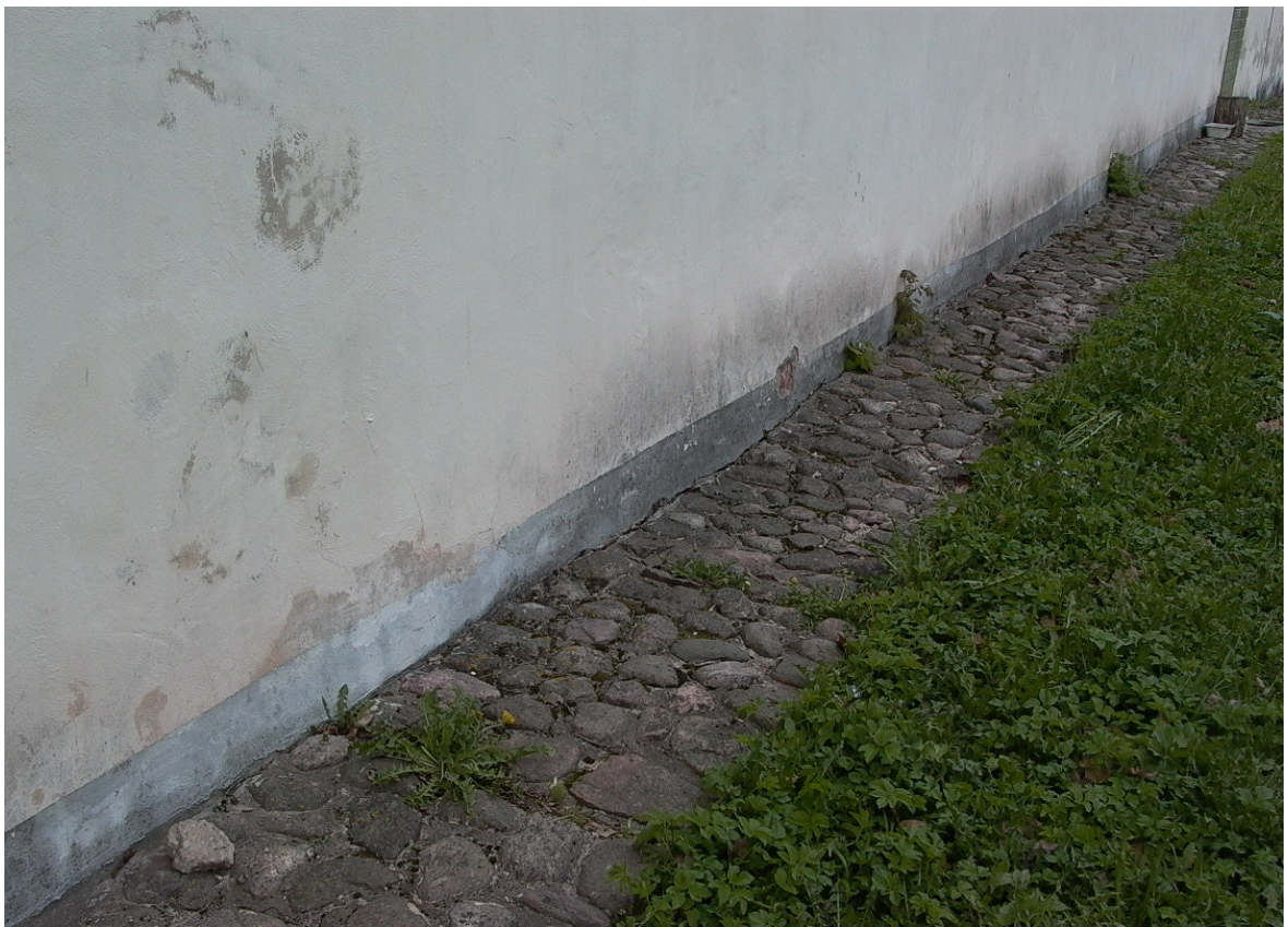
Joonis 21 Vasakpoolse tiibhoone äravajunud kivisillutis
