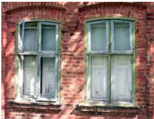
Joon 30. säilinud lengid ja manused
