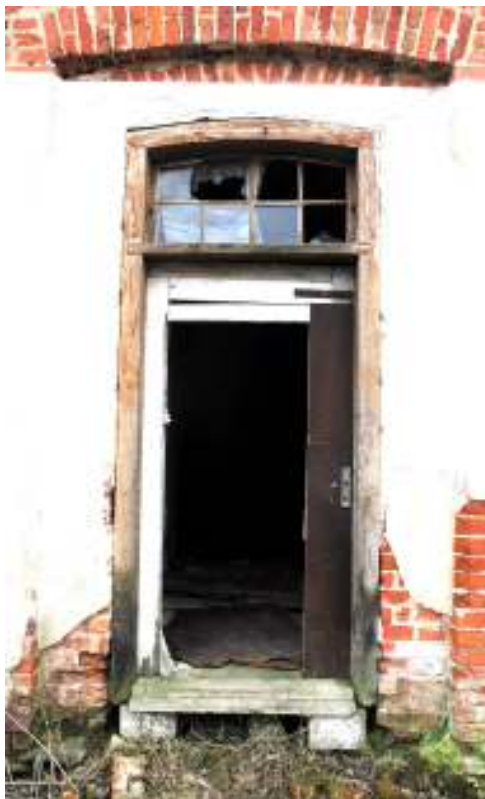
Joon 43. säilinud uksepiit
