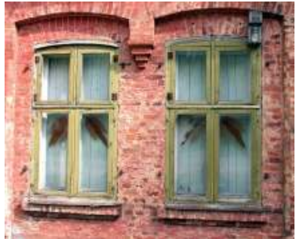
Joon 31. säilinud lengid ja manused
