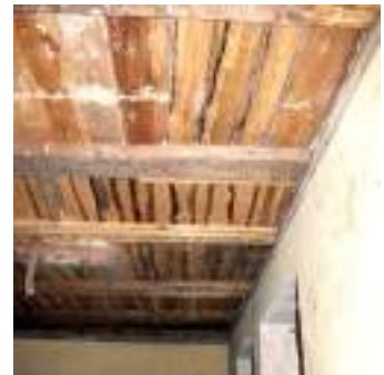
Joon 113-115. vahelae konstruktsiooni nähtavad kahjustused ruumis 11
