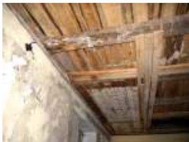
Joon 113-115. vahelae konstruktsiooni nähtavad kahjustused ruumis 11
