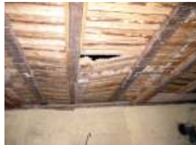
Joon 113-115. vahelae konstruktsiooni nähtavad kahjustused ruumis 11
