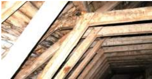
Joon 118, 119. Katuse kandekonstruktsiooni kahjustused
