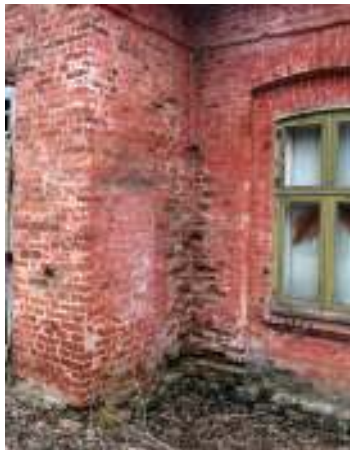
Joon 17. fassaadi kahjustused Joon 18. fassaadi kahjustused Joon 19. fassaadi kahjustused
