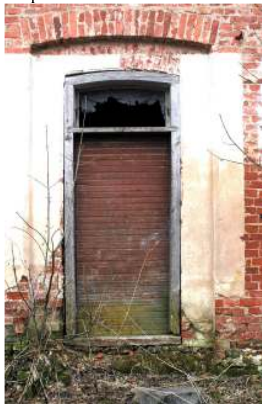
Joon 44. säilinud uksepiit
