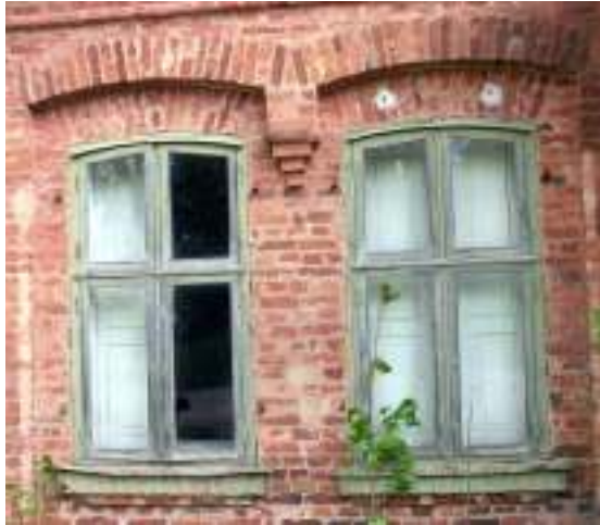
Joon 32. säilinud lengid ja manused
