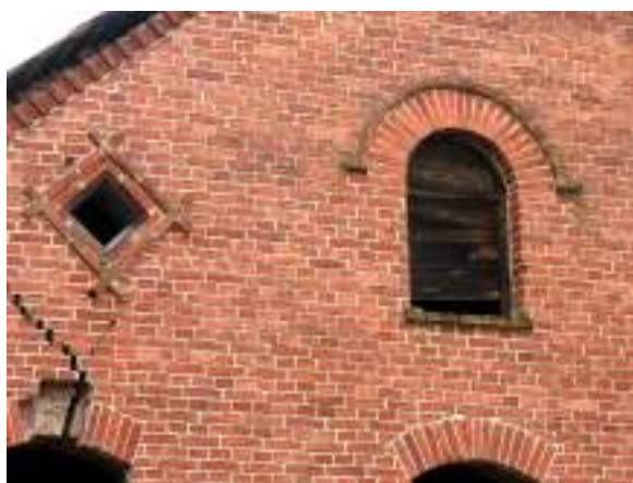
Joon 132. Puhasvuuk müüriladu samal kinnistul asuval laudahooneel
