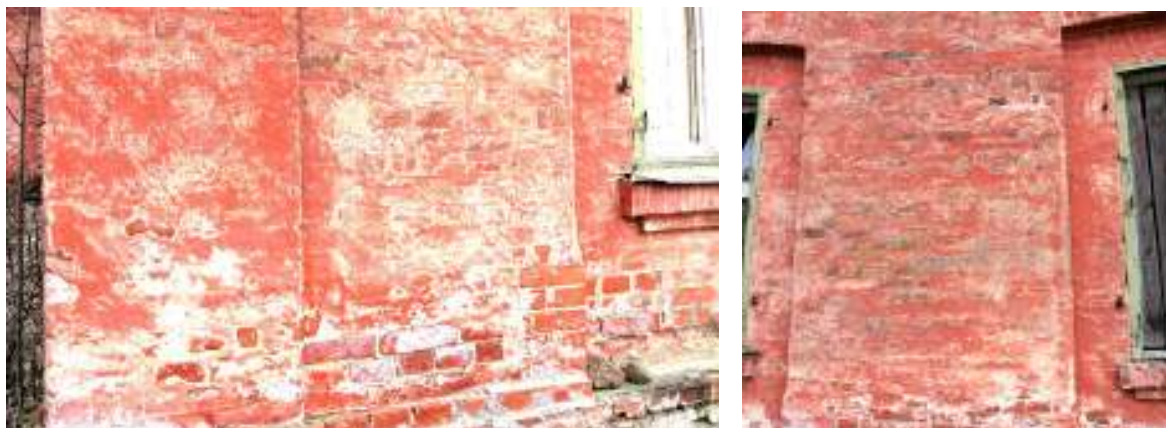
Joon 127, 128. Fassaadi fragmendid krohvi ja värviga
