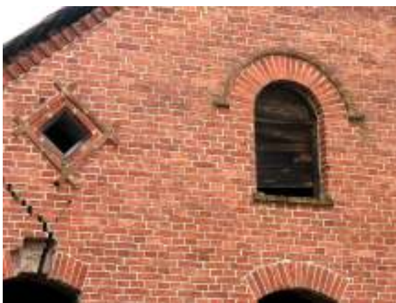
Joon 132. Puhasvuuk müüriladu samal kinnistul asuval laudahooneel
