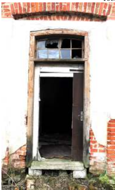
Joon 43. säilinud uksepiit
