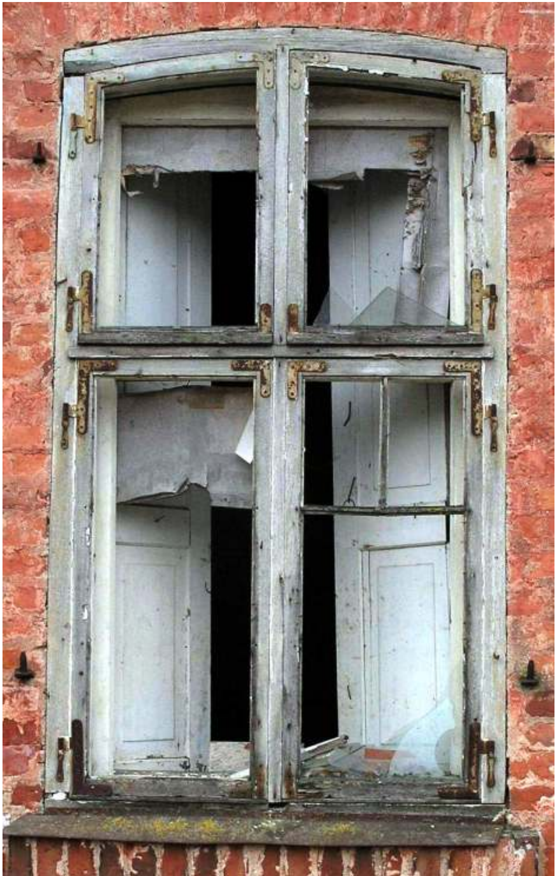
Joon 41. Enim säilinud aken: leng raamid, sj jaotuse fragment, manused
