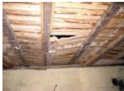
Joon 113-115. vahelae konstruktsiooni nähtavad kahjustused ruumis 11
