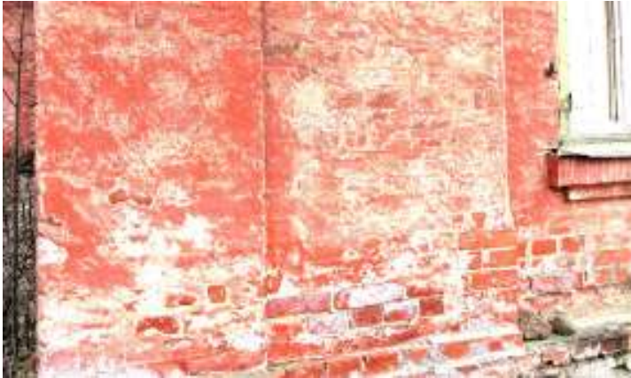
Joon 127, 128. Fassaadi fragmendid krohvi ja värviga
