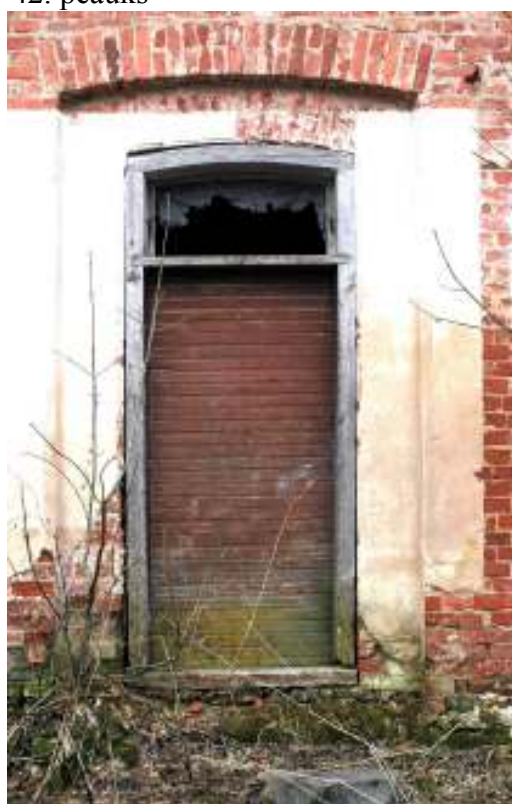
Joon 44. säilinud uksepiit
