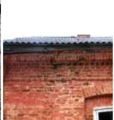
Joon 17. fassaadi kahjustused Joon 18. fassaadi kahjustused Joon 19. fassaadi kahjustused
