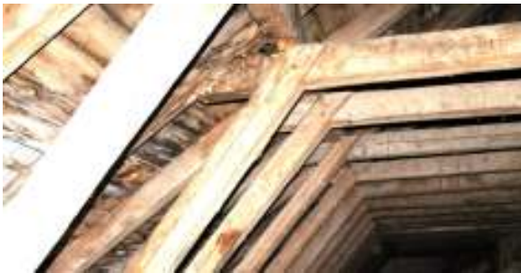
Joon 118, 119. Katuse kandekonstruktsiooni kahjustused
