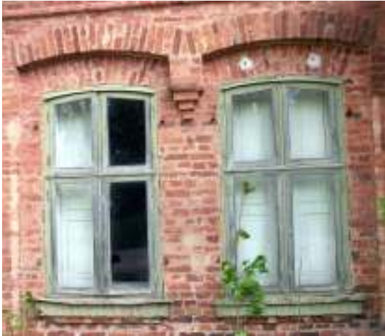
Joon 32. säilinud lengid ja manused
