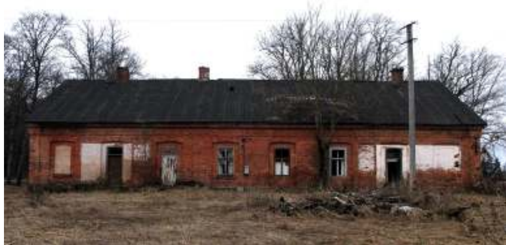
Joon 13. Vaade põhjast
