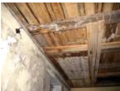
Joon 113-115. vahelae konstruktsiooni nähtavad kahjustused ruumis 11
