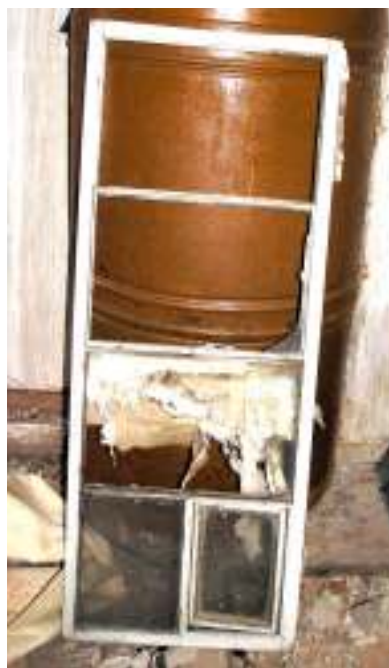
Joon 45. Säilinud 2 k akna fragment
