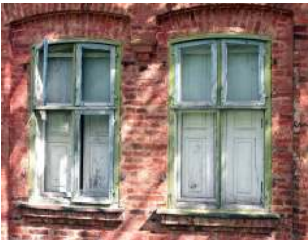
Joon 30. säilinud lengid ja manused
