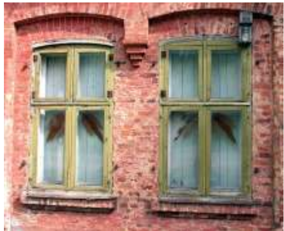
Joon 31. säilinud lengid ja manused
