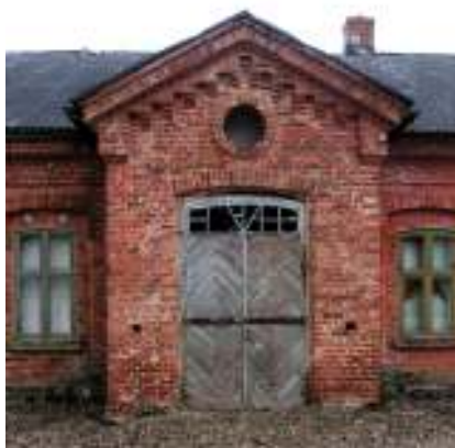
Joon 8. Vaade peasissepääsule
