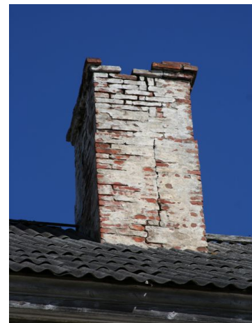
Joonis 6 Lagunenud korstnaots
