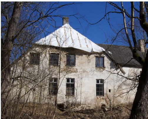
Joonis 5 Hävinenud katusekate lääneküljel
