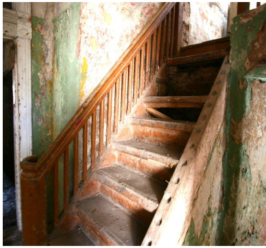
Joonis 17 Hoone vanema osa teisele korrusele viiv trepp
