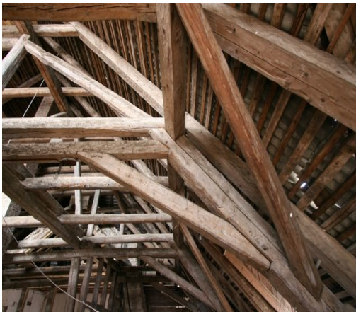
Joonis 3 Puidust katusekonstruktsioon
