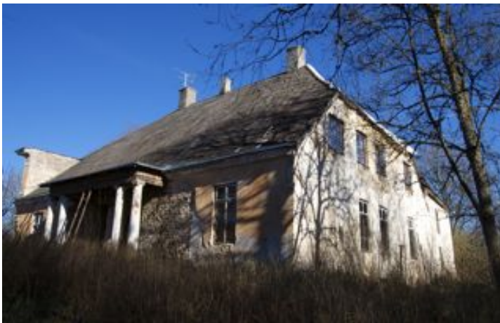
Joonis 8 Vaade mõisa peahoone põhja- ja läänefassaadile
