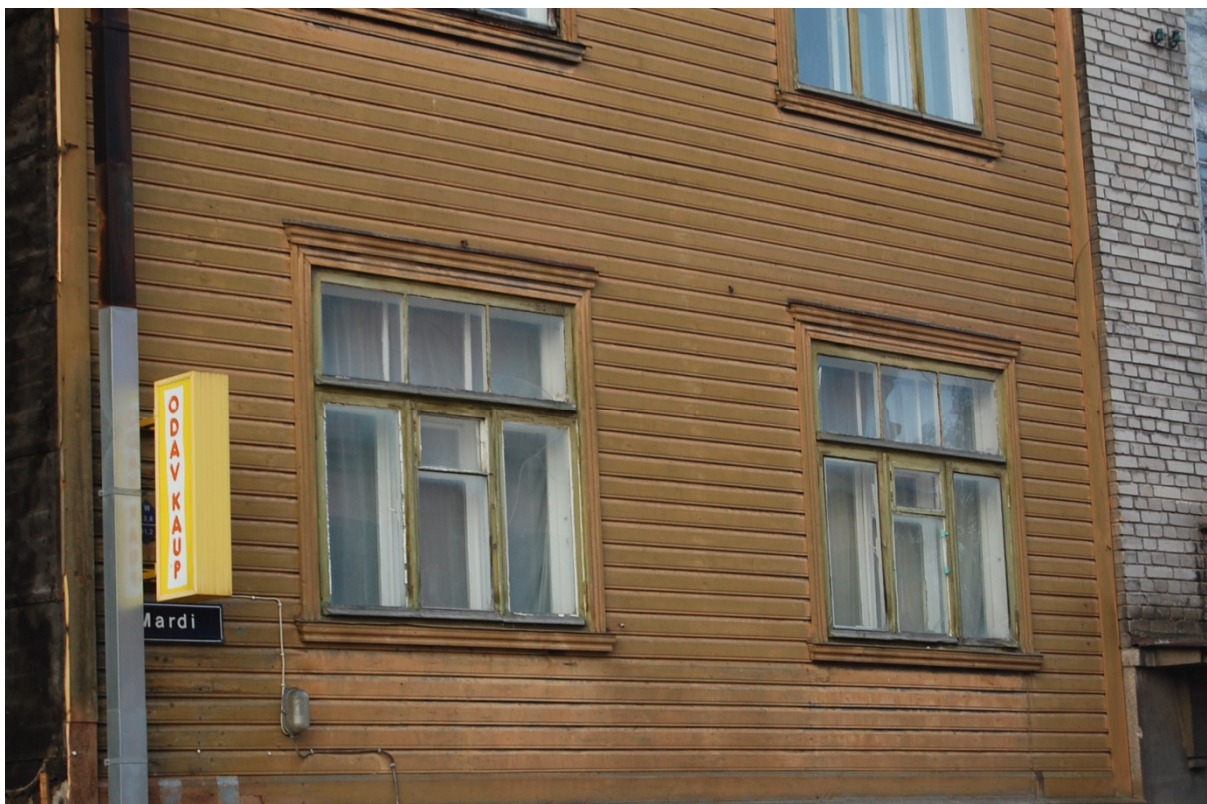
Joonis 6. Säilinud algupärane laudis
