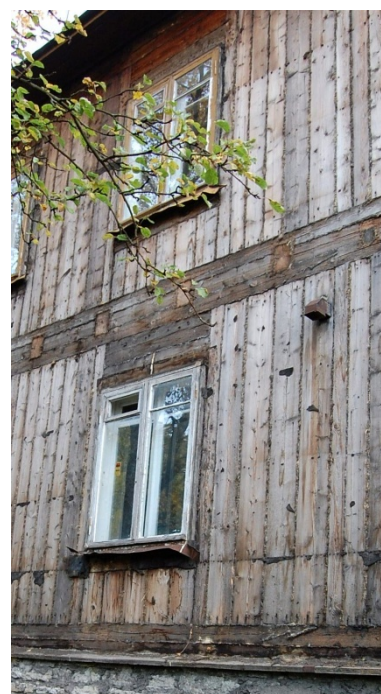
Joonis 14. Hoone nr. 2 seinakonstruktsioonid
