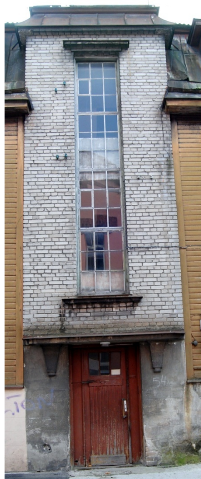
Joonis 18. Silikaat tellistest trepikoda
