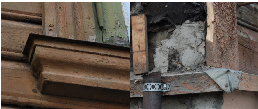
Joonis 7. Säilinud ja pehkinud hoonenurk.
