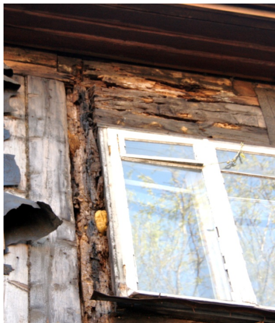
Joonis 15. Pehkinud seinosa
