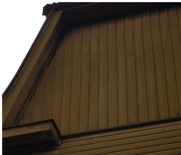
Joonis 8. Otsaviilu säilinud originaallaudis
