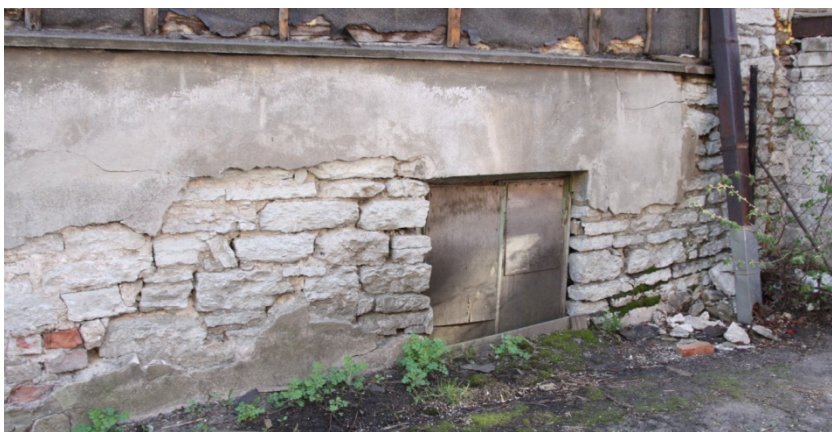
Joonis 13. Pragunenud ja vajunud soklinurk
