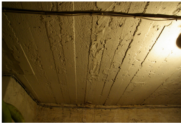
Joonis 27 Kütteaineruumi monoliitbetoonist lagi Autori foto 2010
