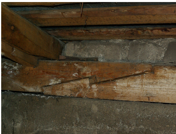
Joonis 14 Müürilatt, sarikas, välissein Autori foto 2010
