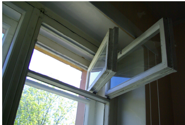
Joonis 7 Kaheraamiline puitaken Autori foto 2010
