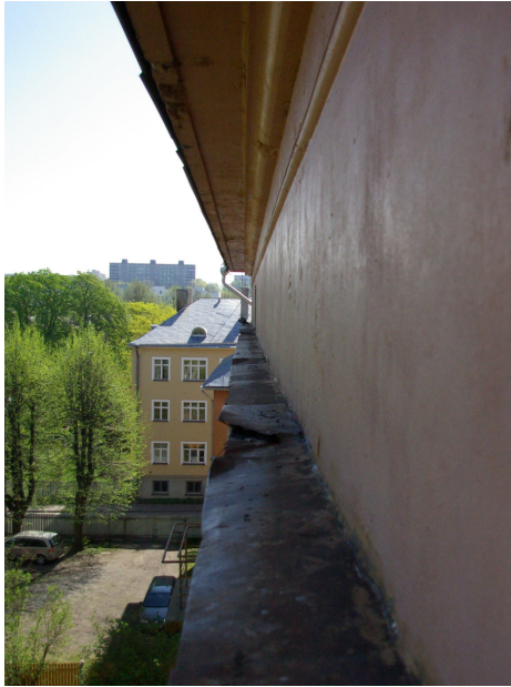
Joonis 23 Karniisiplekk Autori foto 2010
