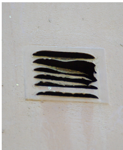
Joonis 33 Ventilatsiooniava fassaadil Autori foto 2010
