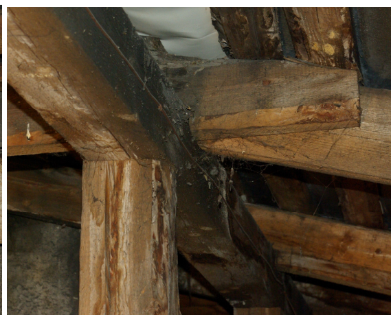
Joonis 15 Toolvärk, sarikas, penn Autori foto 2010
