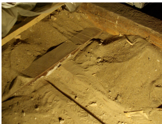
Joonis 3 Pööninglae konstruktsioon Autori foto 2010
