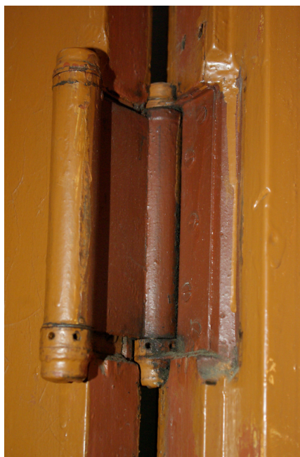
Joonis 9 Ukse pendelhing Autori foto 2010
