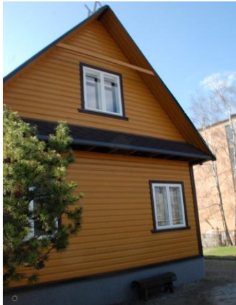
11. Renoveeritud veranda ja teise korruse maht (vaade idast).
