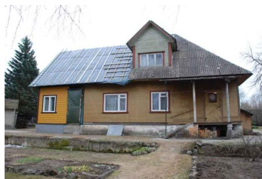
6. Vaade põhjast (hoovi poolt).
