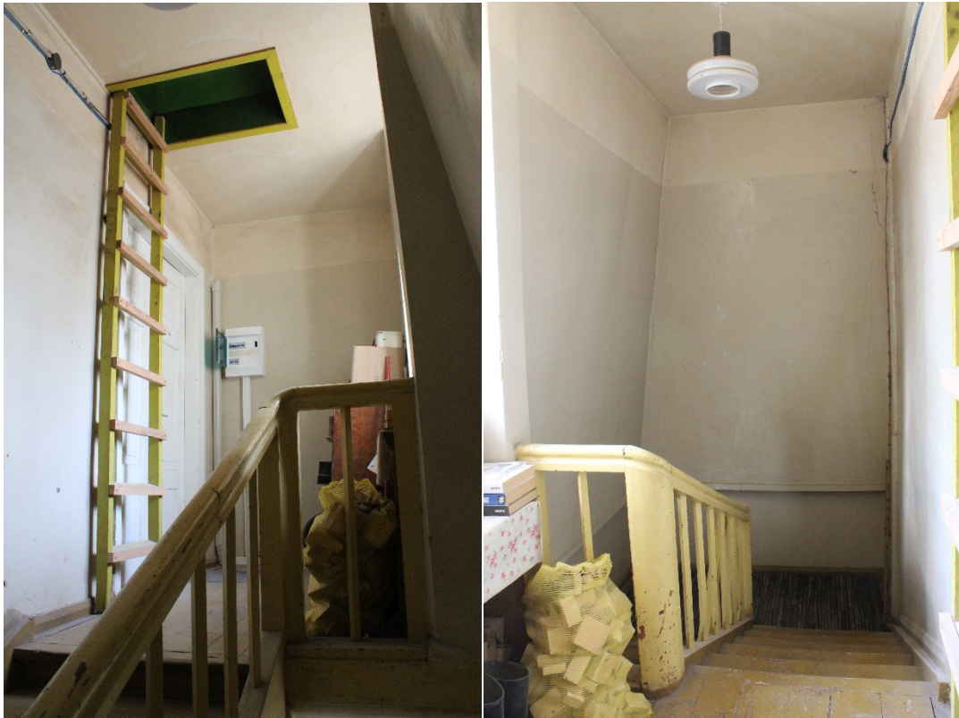
Foto 103, 104 Trepikoja puittrepp, 2. korrus ja pääs pööningule.
