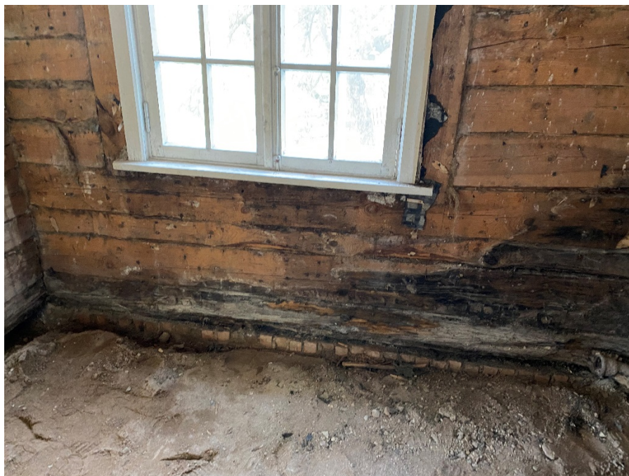
Foto 9 Põrandate lahtivõtmisel paistab sokli tellistest ülemine serv. (P.Eero foto).
