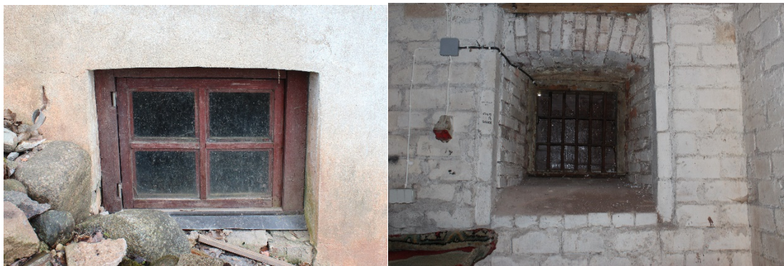
Foto 91 Keldri väiksemõõdulised aknad. Hoovipoolne väljast ja Trepimäe poolne seest.
