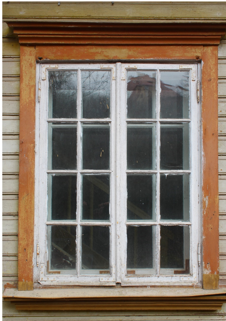
Foto 84 Hoone tüüpne 16 jaotusega aken. 1. korruse trepikoja akan, säilinud algsel kujul.
