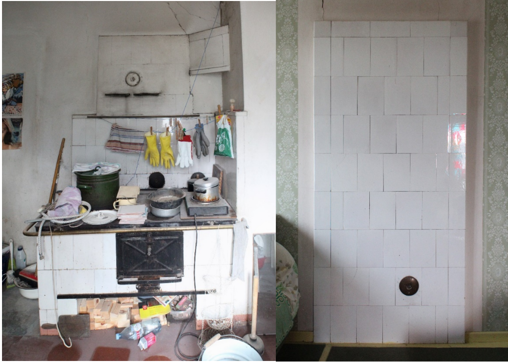
Foto 116 Teise korruse pliit ja soemüür.
