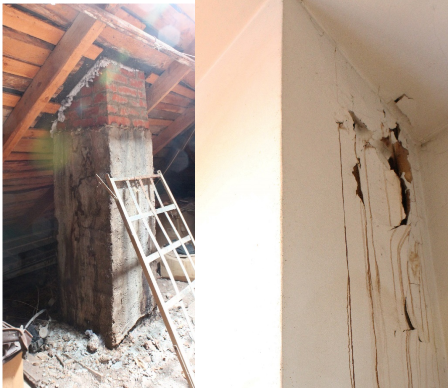
Foto 47 Pööning – kolmas korsten.
