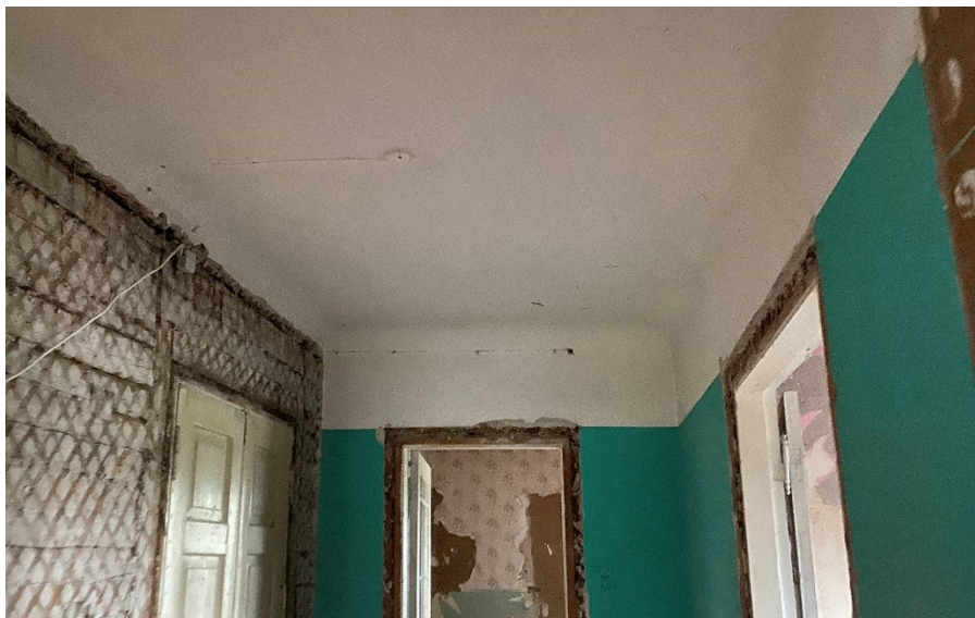
Foto 42 1. korruse esiku peegellagi enne remonti ja väljalõhkumist. (P.Eero foto).
