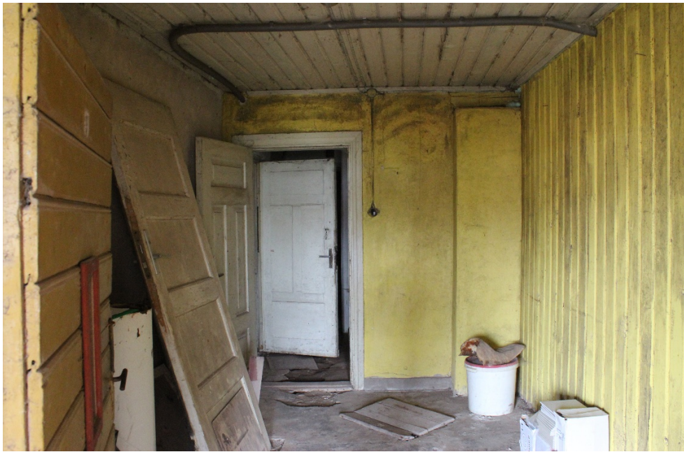
Foto 38 Keldri eesruum, profileeritud lauast lagi, krohvitud seinad, puidust kergvaheseinad.
