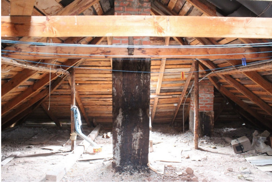
Foto 46 Pööning, näha robustselt kokku klopsitud konstruktsioon ja kaks korsten.
