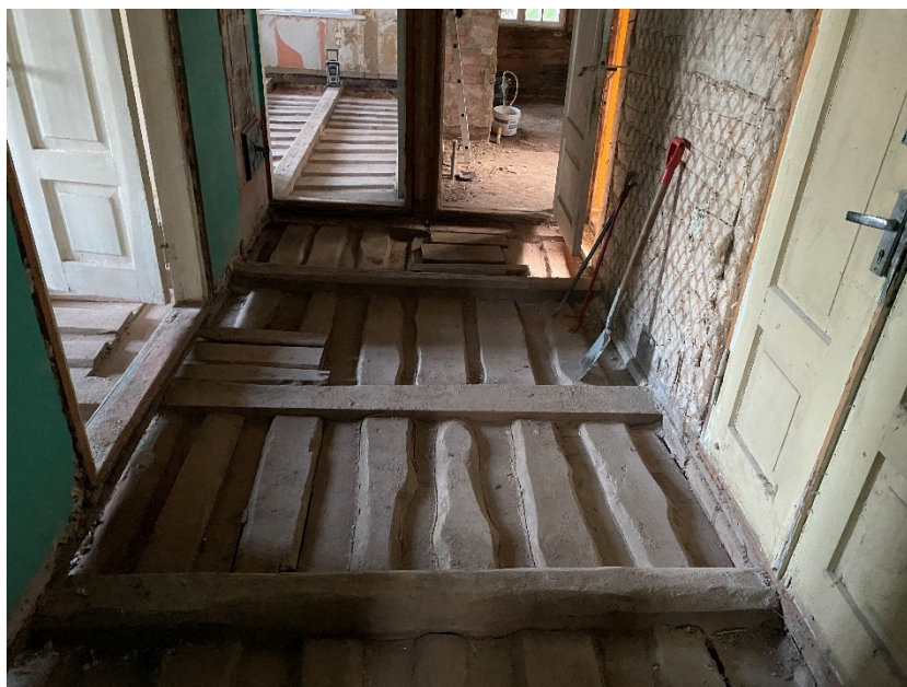
Foto 36 1. korruse lahti võetud põrandad. Näha laudpõrandad ja köögi betoonpõrand. (P.Eero foto).
