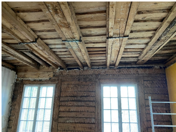
Foto 40 1. korruse sosas lahti võetud laed. Nähakrohivialuse laastumati jälgi seinal. Talad on olnud tugevdatud lisa raudadega. (P.Eero foto).
