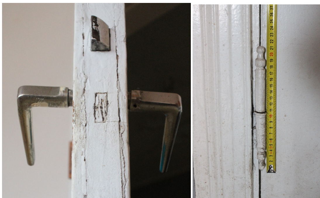
Foto 72 Keskmise toa ukse link.
