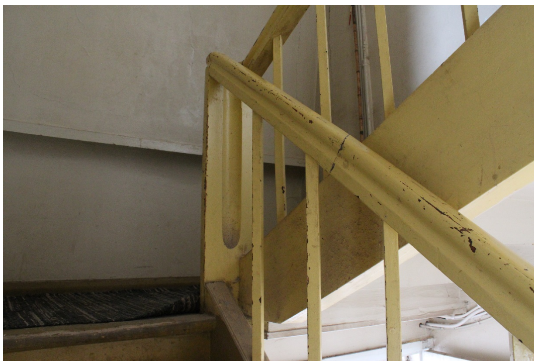
Foto 102 Trepikoja puittrepp, vahemade.
