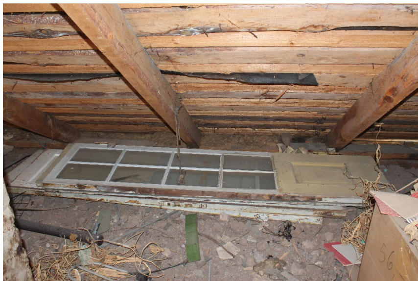
Foto 63 Pööningult leitud algsed terrassi ja tagumise külje välisuksed.
