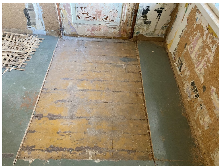
Foto 22 1. korruse laudpõrand konstruktsioonide aamise käigust. (P. Eero foto)
