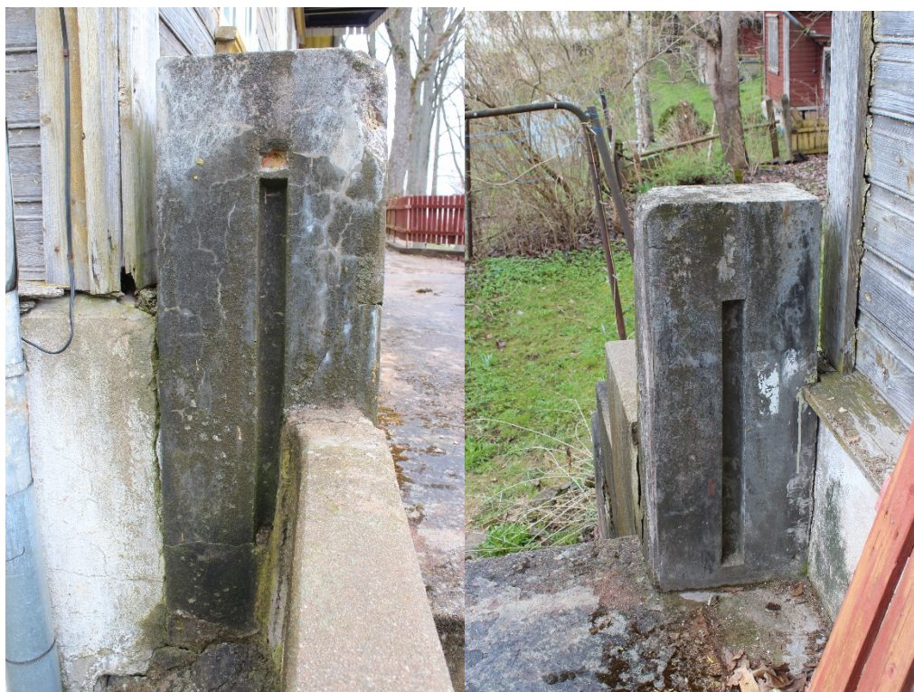
Foto 18 Säilinud terrassipiirde betoonist nurgapost 2.
