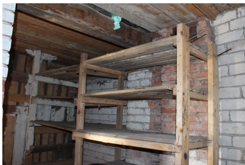
Foto 37 Näha keldribokside mustast lauast lagi, ning seinte toetus silikaattellisega.
