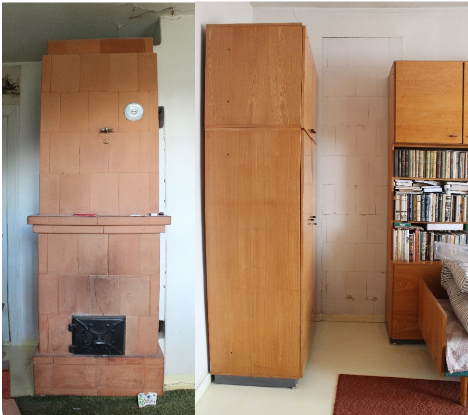
Foto 118 Teise korruse Trepimäe poolse toa ahi, säilinud originaal ahjuuks ja siiber.
