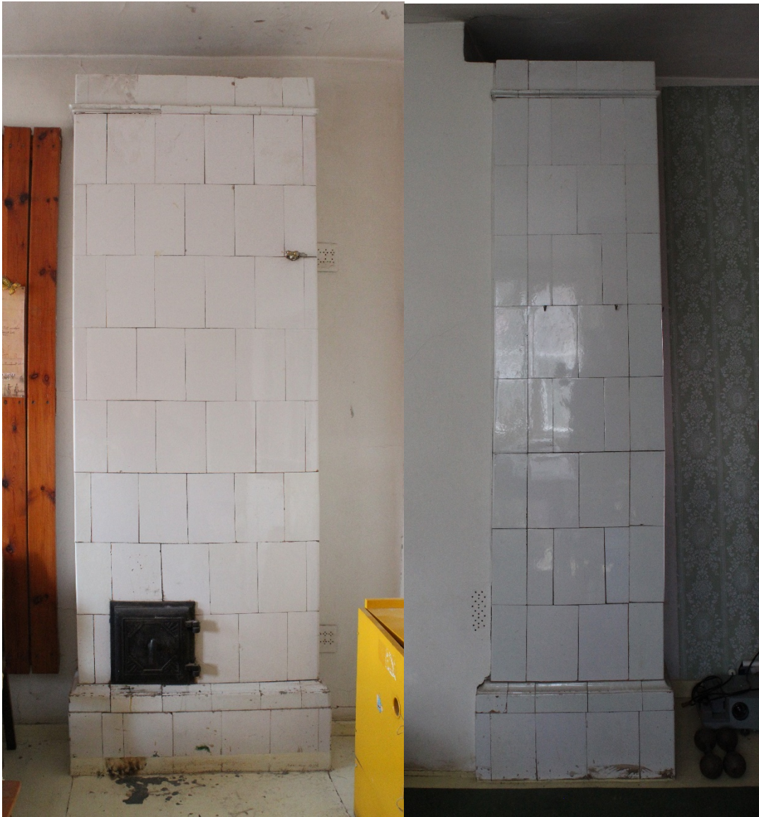
Foto 120 Teise korruse keskmise toa ahi, säilinud originaal siiber.
