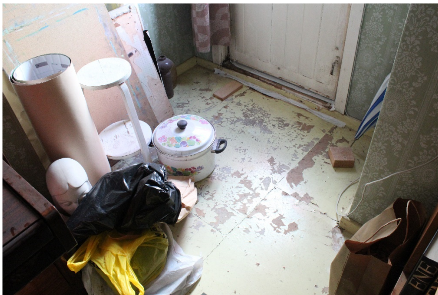
Foto 43 2. korruse puitkiudplaadiga kaetud põrand rõdu ukse juures.
