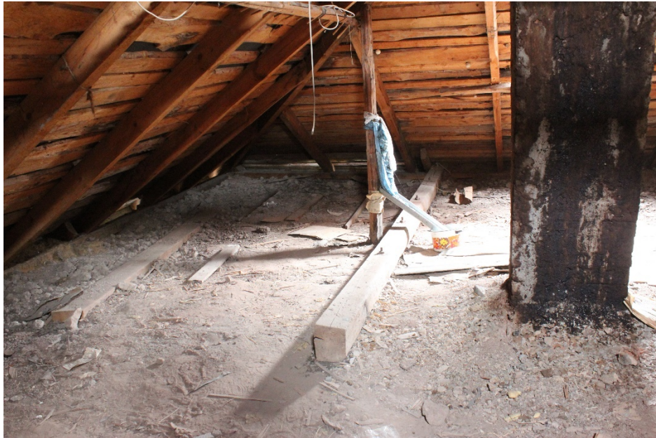
Foto 45 Lisa toestustala pööningul suure toa silde vähendamiseks.
