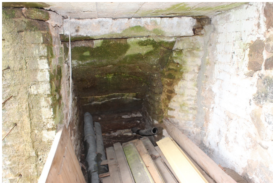
Foto 97 Betoon trepi alune.
