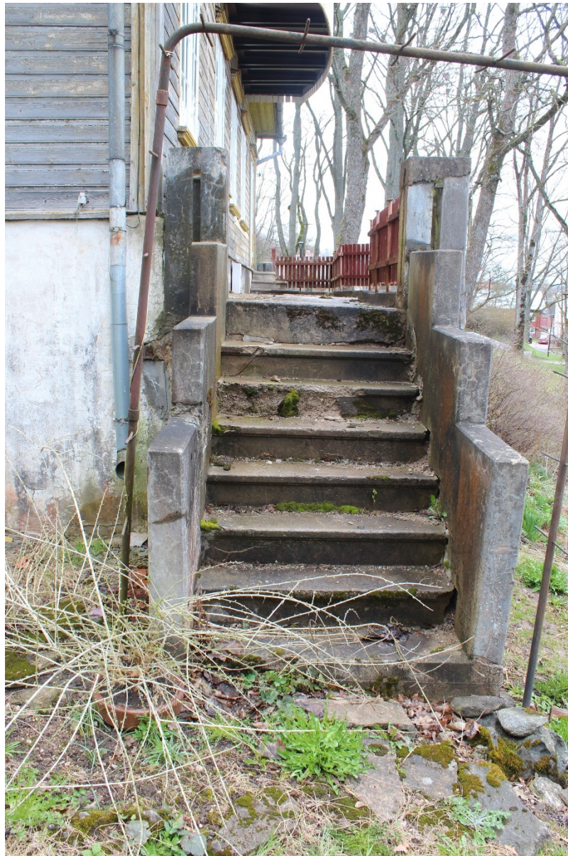
Foto 95 Betoon trepp tõstetud terrassile.
