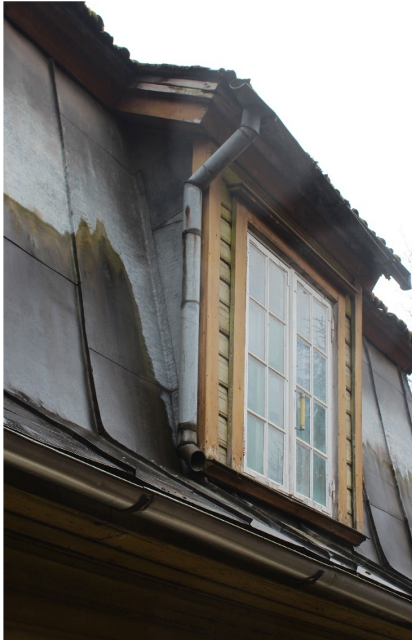
Foto 52 Mansardi uuk akendel oma vihmaveesüsteem.
