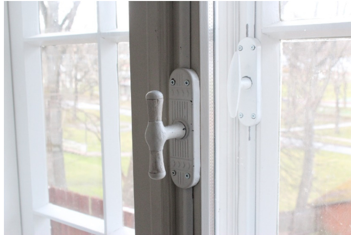
Foto 83 Esimesel korrusel uutele akendele pandud vanad kremoonid. Tervenisti üle värvitud.
