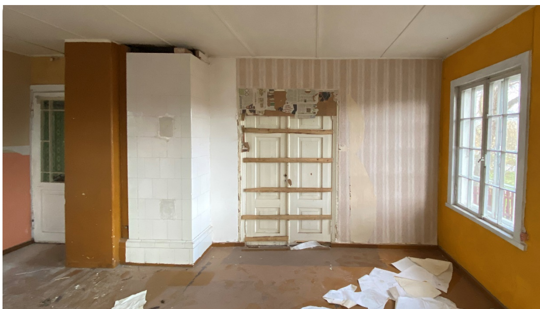
Foto 64 Remonttööde käigus seina seest välja tulnud uks 1. korrusel (P.Eero foto)
