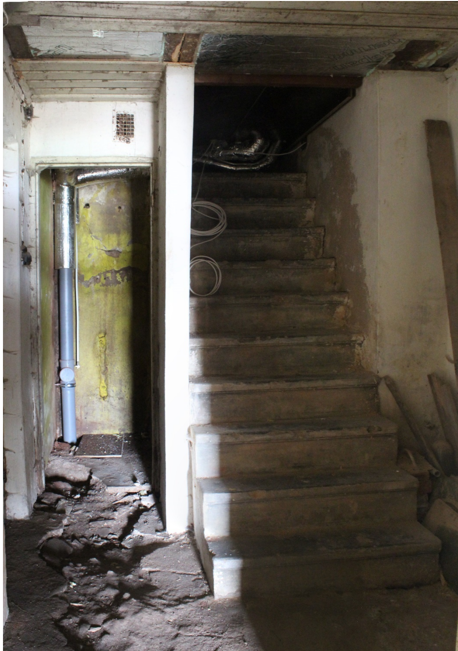
Foto 98 Keldri betoontrepp, mis viis kunagi 1. korrusele.
