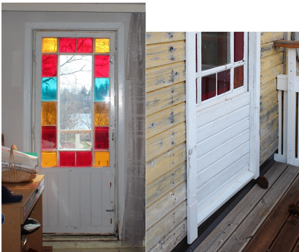
Foto 74 Rõdu uks, vaade seest ja väljast.
