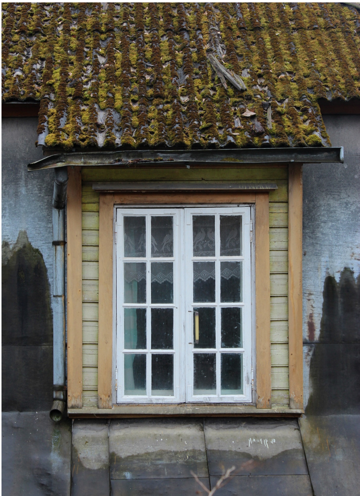
Foto 89 Mansardi ühe aknaga uuk. See konkreetne köögi oma, välimisel aknal kõik prosspulgad alles, sisemisel kõik puudu.
