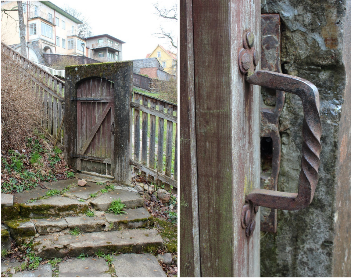
Foto 126 Betoon raamis puitvärav, latt sepishingede ja sepiskäepidemega.
