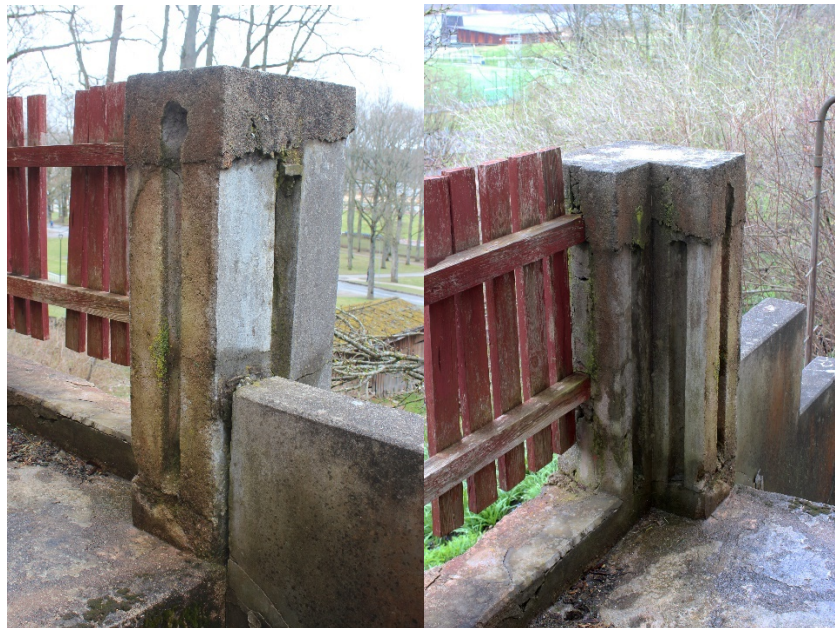
Foto 17 Säilinud terrassipiirde betoonist nurgapost 1.
