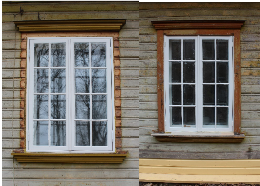
Foto 85 1. korteri akand, osad veel piirdelaudadeta. Kominatsioon restaureerimisest ja uutest akendest.
