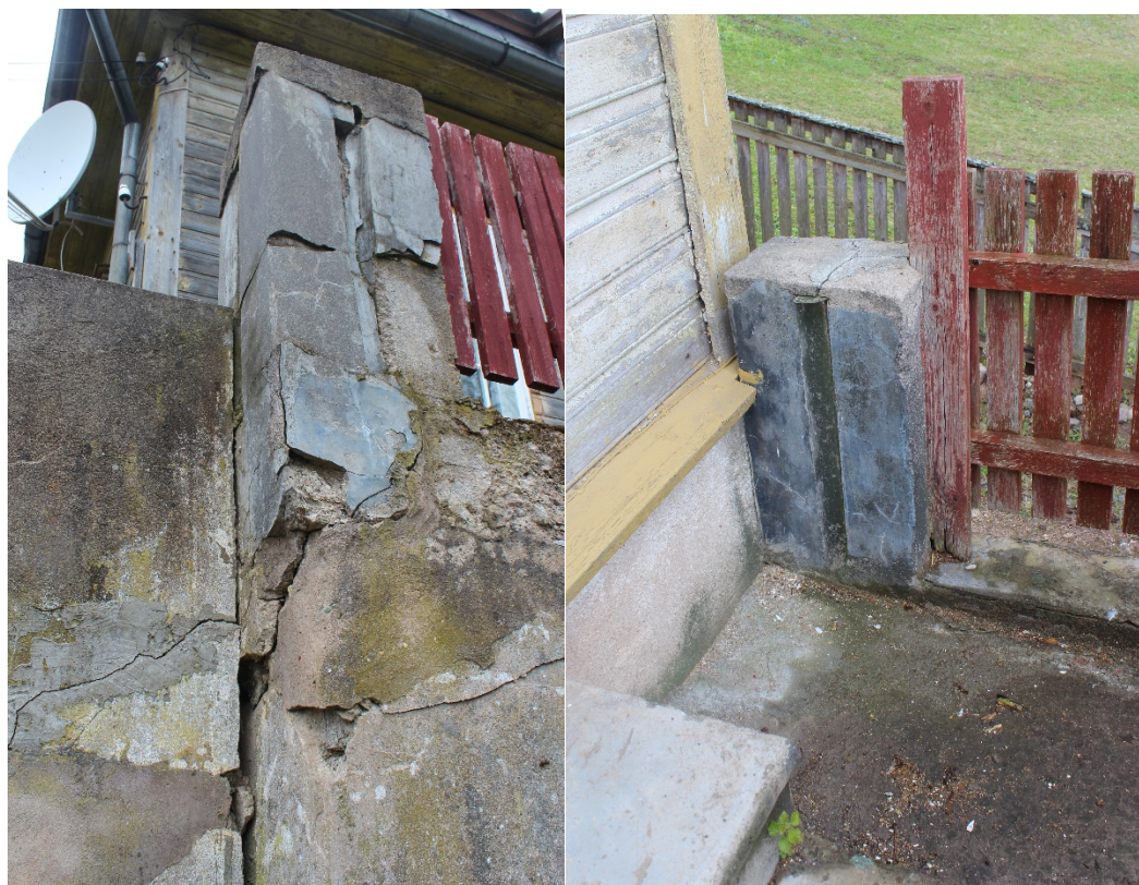
Foto 19 Säilinud terrassipiirde betoonist nurgapost 3.
