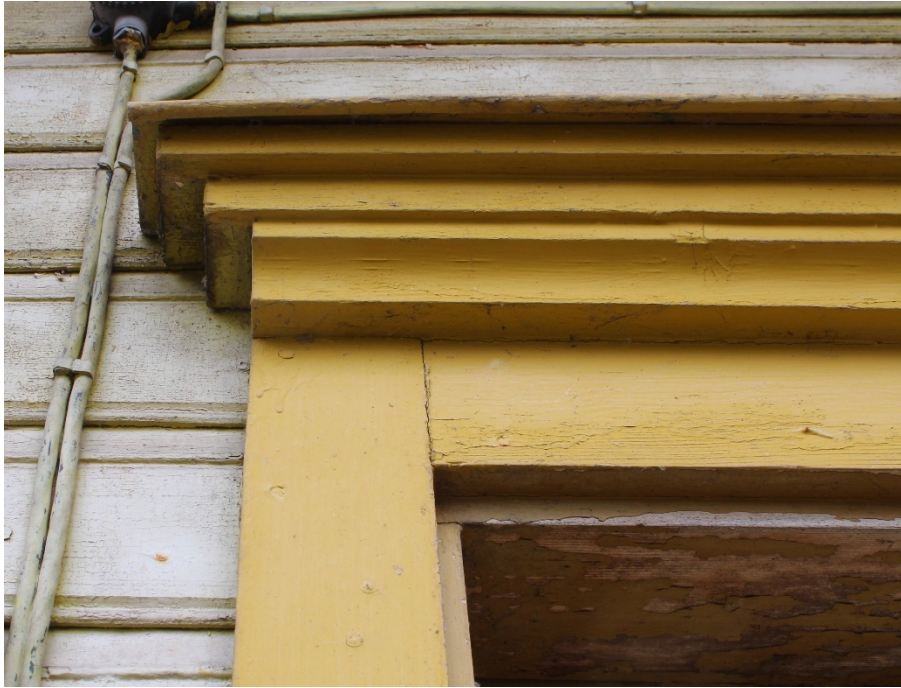
Foto 29 Avade kohal paikneva karniisi versioon 1.
