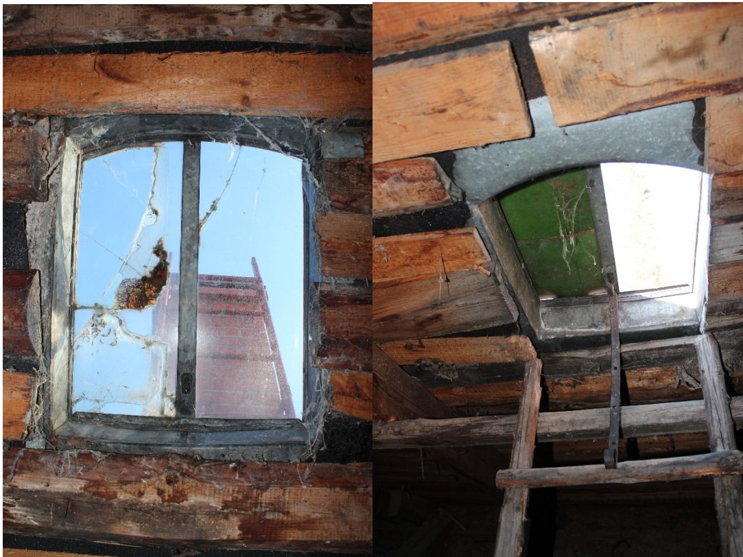
Foto 49 Pööningu terasraamis luugid, katusele pääsuks.
