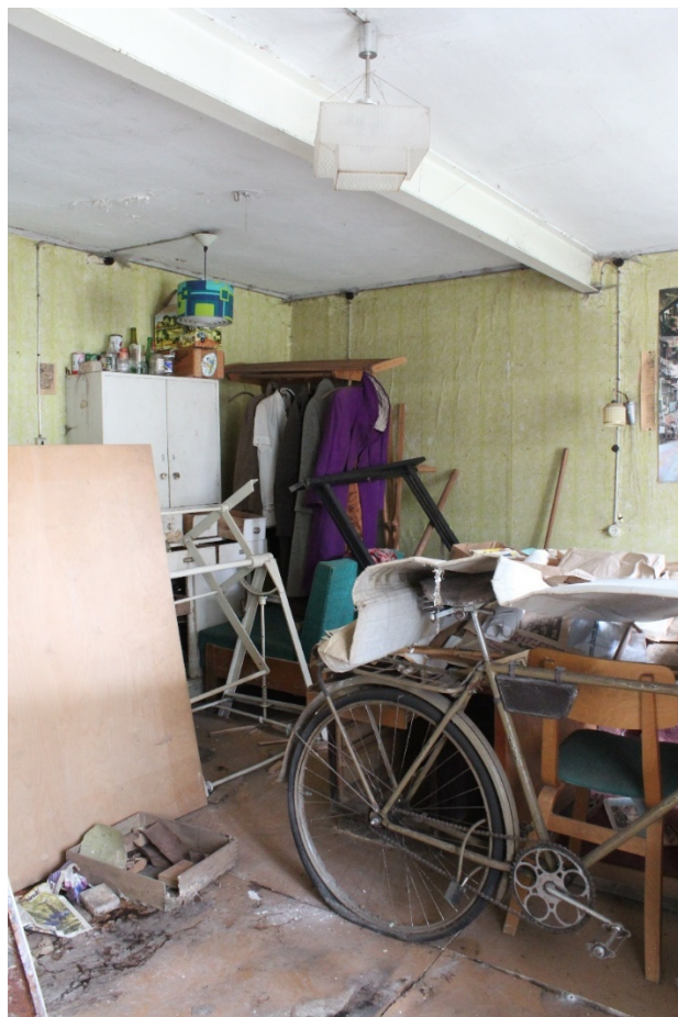
Foto 39 Köök-tuba kaldris, niiskuskahjustustega põrandad ja seinad. Laen näha lisatoetus terastala näol.
