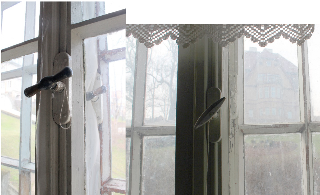
Foto 82 Enamus akendel alles originaal kremoonid, mõned asendatud nõukogude aegsetega.
