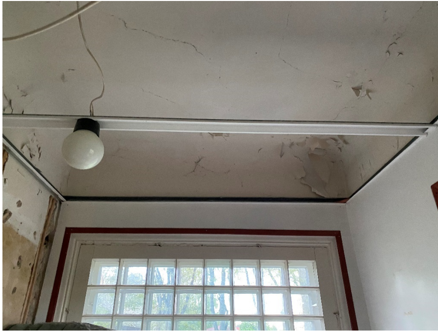
Foto 41 1. korruse veranda peegellagi enne remonti ja väljalõhkumist. (P.Eero foto).
