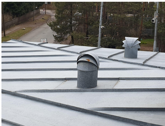
Foto 2. katus ja sademevee süsteemi
