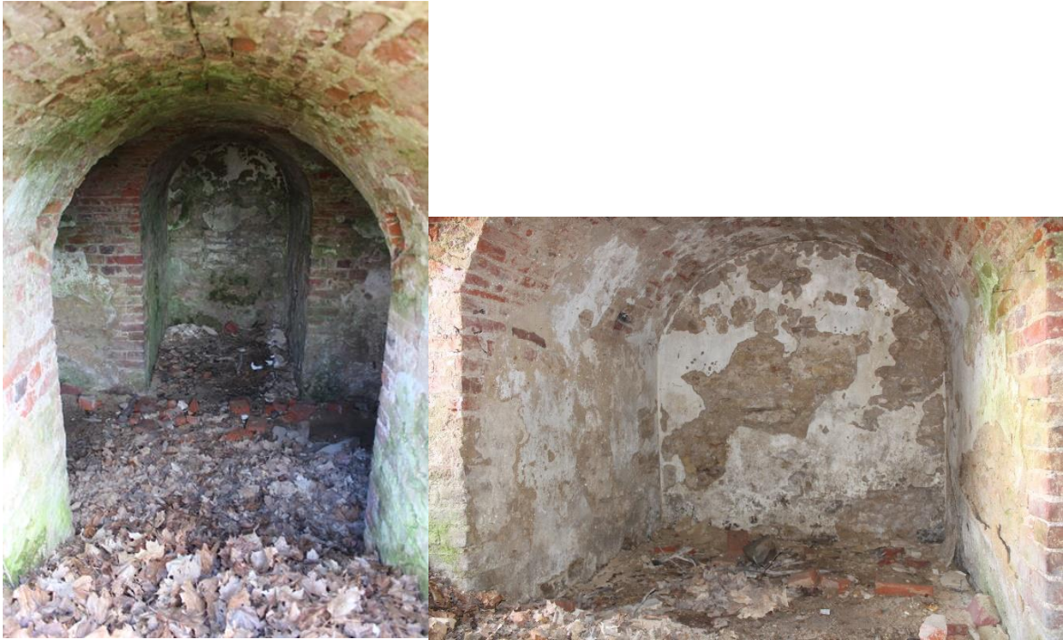
Foto 17 ja 18. Hauakabeli sisevaated 28.04.2021.
