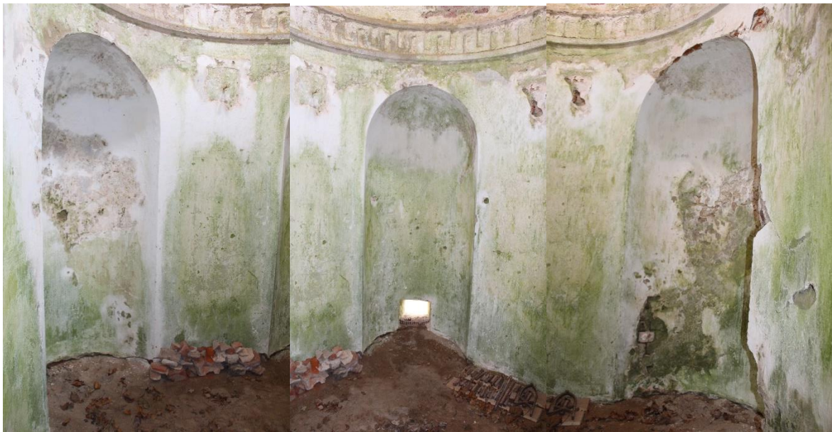
Foto 11, 12 ja 13. Kabeli sisevaade 28.04.2021.
