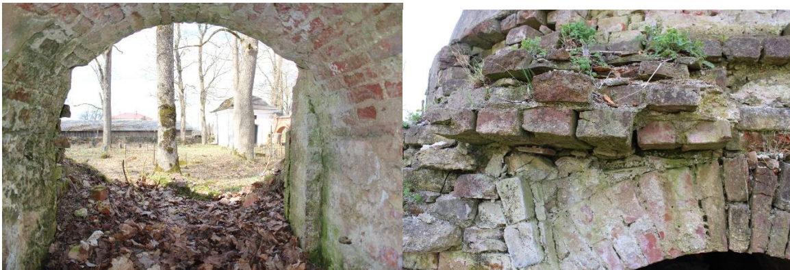
Foto 15 ja 16. Hauakabeli sissepääsu detailvaated 28.04.2021.
