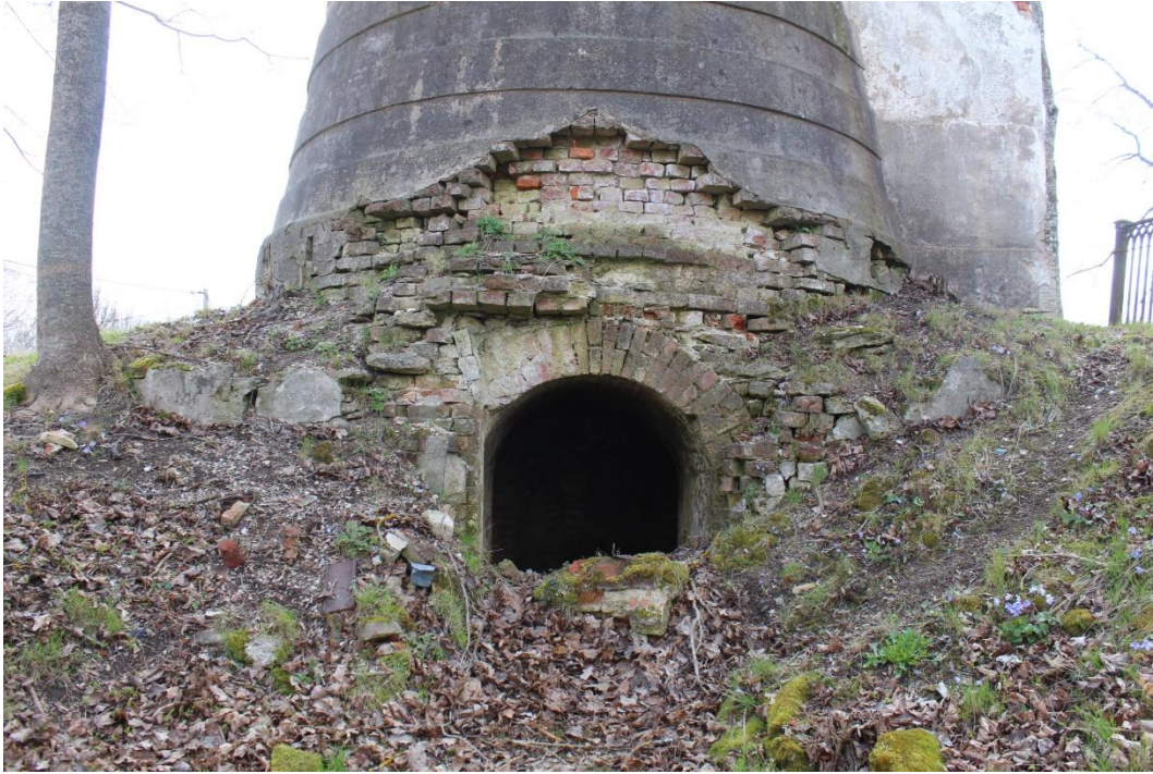
Foto 14. Maa-aluse hauakabeli sissepääs 28.04.2021.
