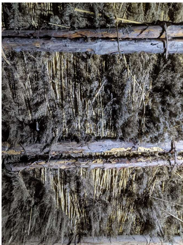
30. Vaade rookatusesele ja roovidele altpoolt
