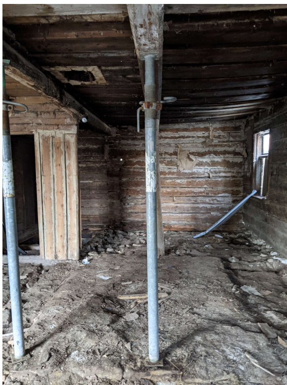
35. Vaade kunagisele korstnale ja selle alusele vundamendile
