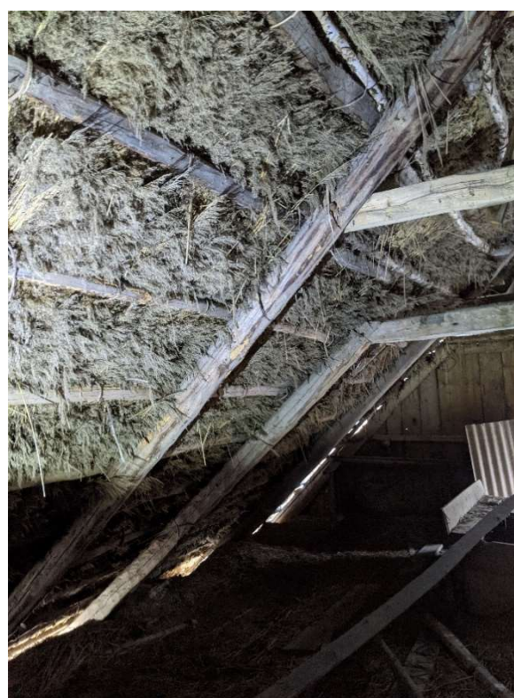
31. Vaade katusekonstruktsioonile altpoolt
