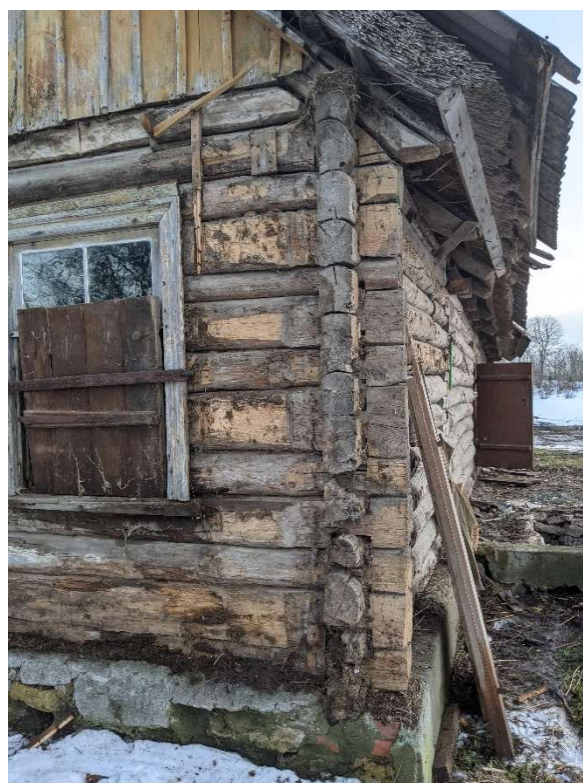
29. Vaade räästasõlmele loodenurgas
