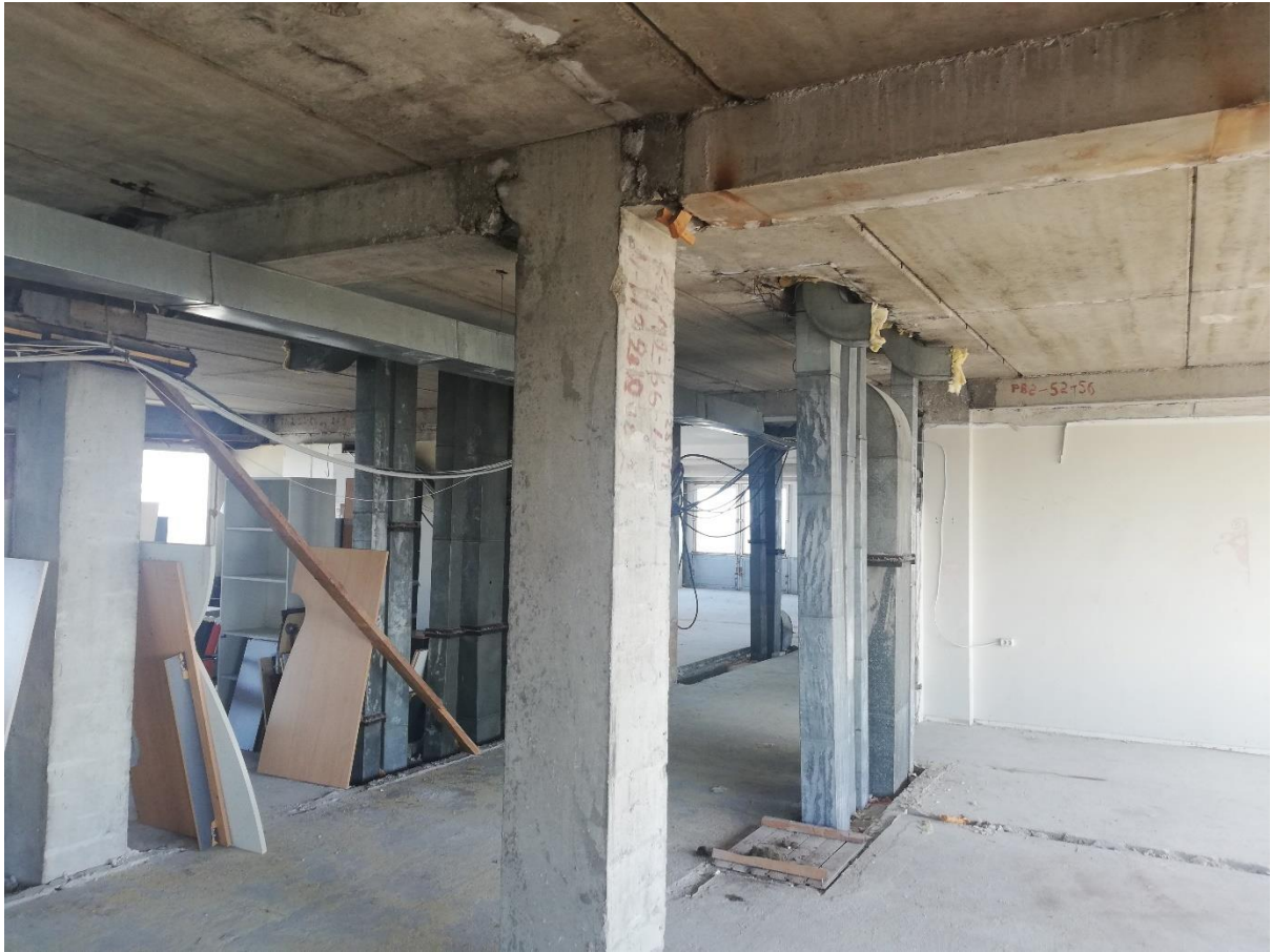
III 18. Betoonist post-tala konstruktsioon.
