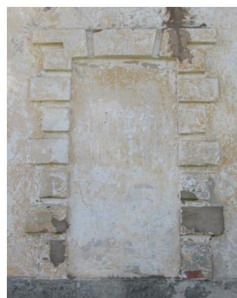
26. Ukseava imiteeriv kvaader hoone põhja poolses otsas
