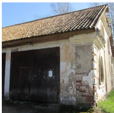
22. Samas lääne poole jääv liseen, millelt krohvikiht on koordunud
