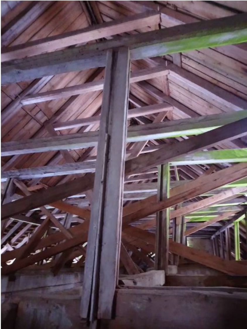
20 Pööningul paljastuv katuse kandekonstruktsioon, 2017. Autori foto
