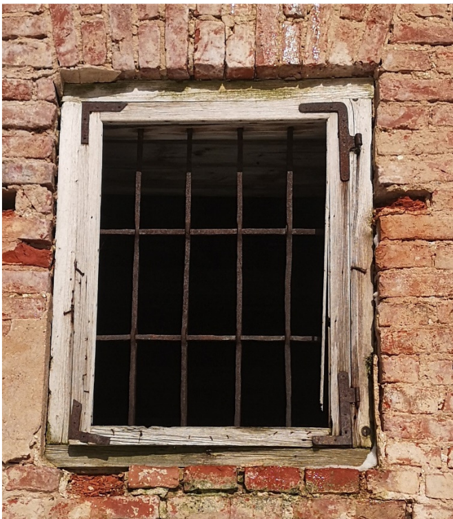
35 Säilinud metallist detailid aknaraamis, märts 2021. Autori foto
