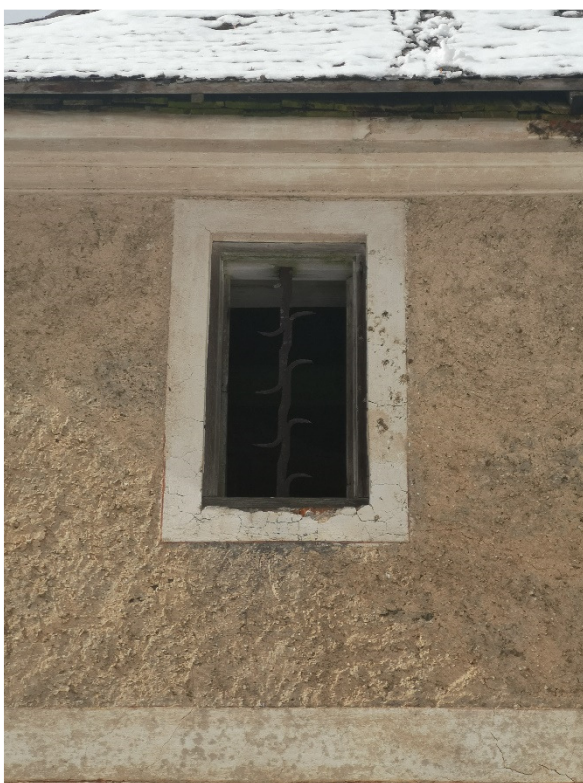
24 Säilinud räästakarniis, hele raamistu ja krohv, märts 2021. Autori foto
