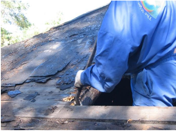
III.33 Töömees kõrvaldab mädanenud laudu ja vana tõrvapappi. Näha on 36 aastaga kogunenud 4 kihti tõrvapappi.
