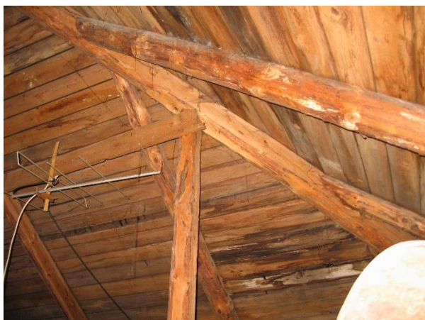
III.31 Vaade vana osa katusealusele. Sarikateks on kasutatud kooritud ja veidi tahutud mände. Nähtavasti pärinevad need siit samalt krundilt.
