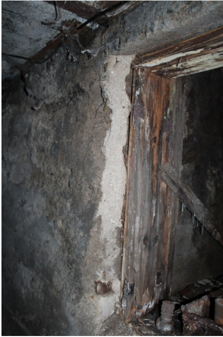
Foto 7. Kahjustunud aknalengid keldri müüris. Valguskaevis on väljast kaetud
