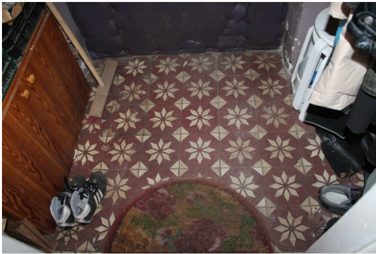
Foto 36. Ehitusaegsed põrandaplaadid
