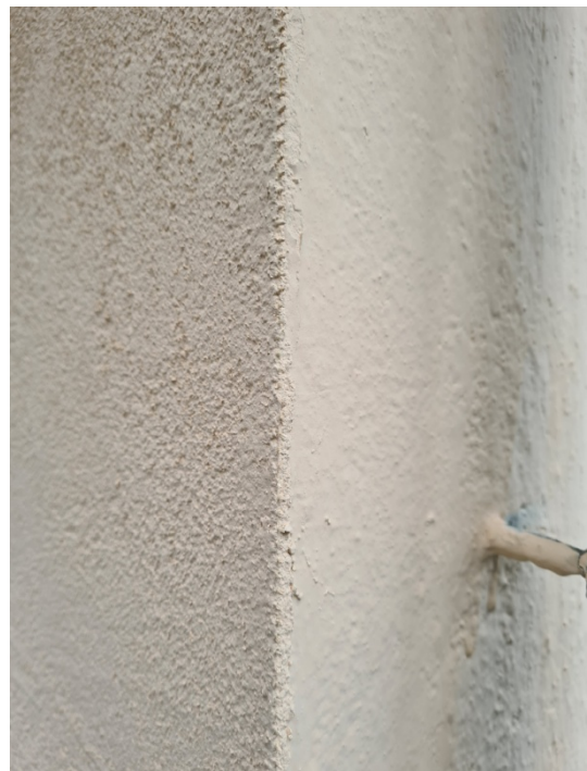
Foto 12. Vasakul küljel uus lubikrohviga pind,
