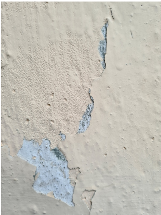
Foto 11. Värvipind lähivaates. Tumedad laigud on tsementkrohv, krobeline pind tuleb alumisse valge lubivärvi kihti tekkinud krakleest.
