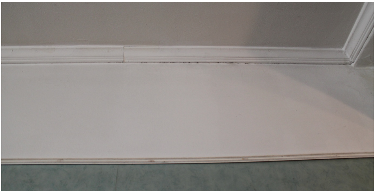
Foto 37. Tapeediliist ja pingupapist lagi koos servaliistuga esimese korruse elutoas
