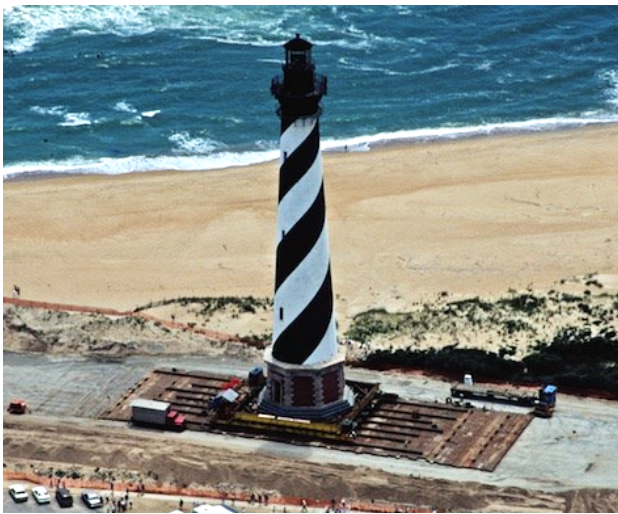
12. Cape Hatterase tuletorni teisaldamine 1999. aastal. (National Park Service)
