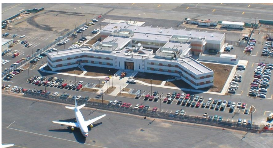
19. Newarki Lennujaama hoone nr 51. (Beyer Blinder Belle)
