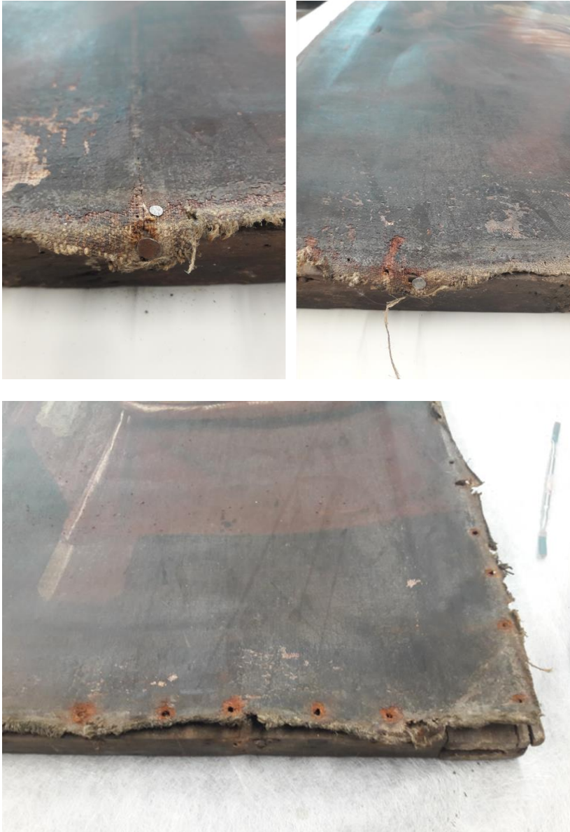
Joonis 65. 1. ja 2. pildil nähtavad tööstuslikud naelad, tõenäoliselt Nõukogude perioodist. Alumisel pildid on näha kahjustunud äärist ning kuidas sepanaelte korrodeerumine on lõuendit kahjustanud.
