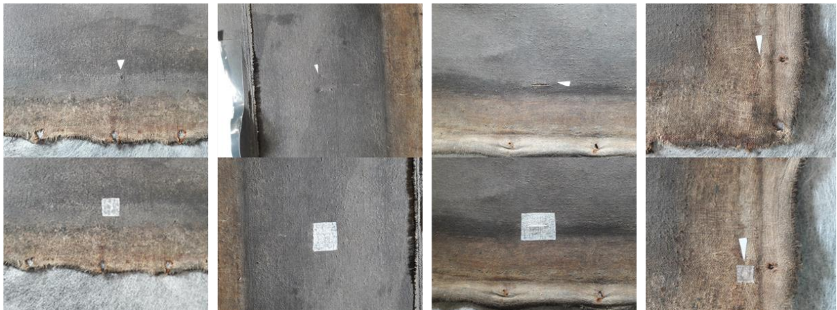
Joonis 77. Teine rebenditüüp, rebendid enne ja pärast toetuslapiga dubleerimist.
