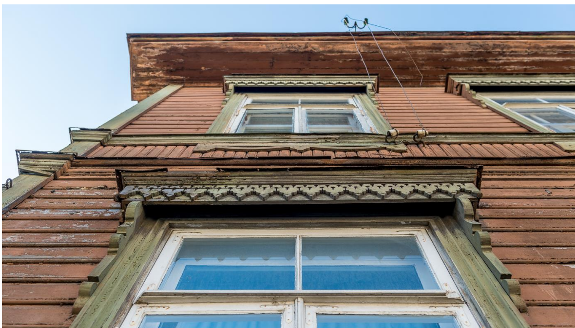
Illustratsioon 38. Tehnika 7, akende kaunistused (sandrik, ehiskandur, profileeritud piirdeliist). Foto Margus Vilisoo 23. aprill 2018.a.
