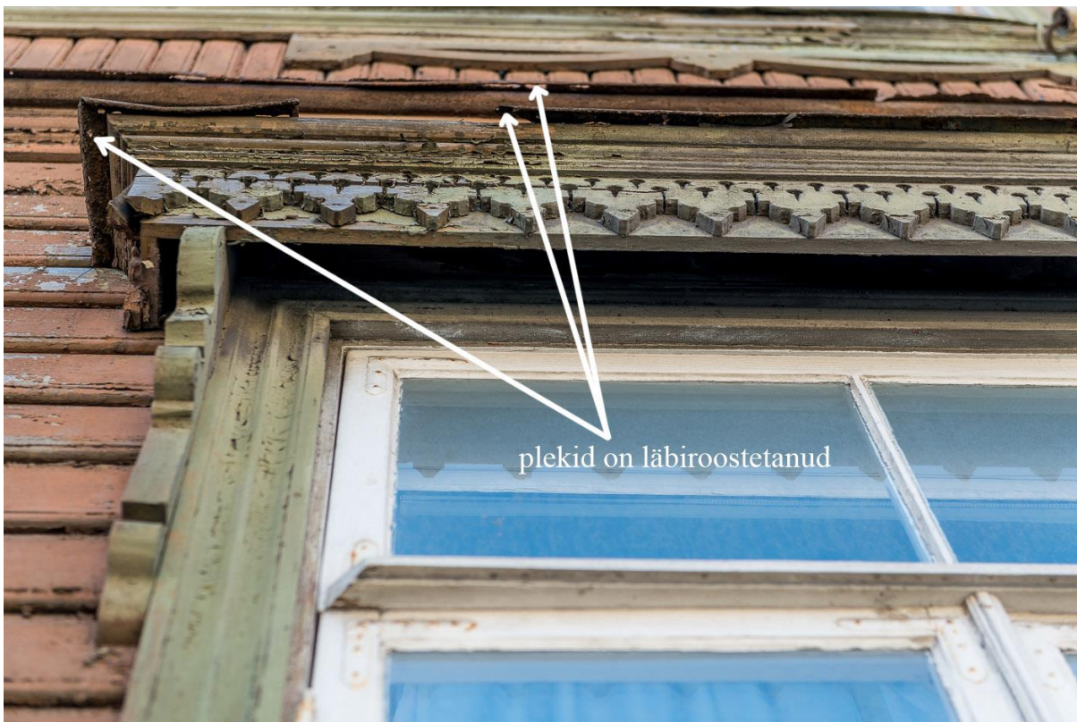
Illustratsioon 52. Tehnika 7, plekid on kohati läbiroostetanud. Foto Margus Vilisoo 23. aprill 2018.a.
