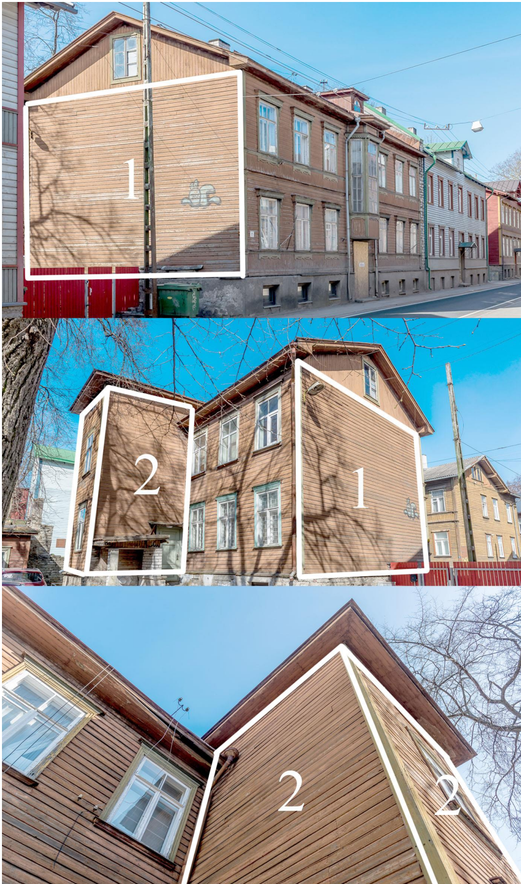
Illustratsioon 69. Välisseinte soojustustöödeplaan. Foto Margus Vilisoo 23. aprill 2018.a.
