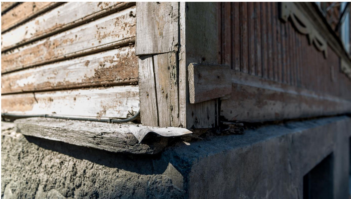
Illustratsioon 49. Tehnika 7, Tänavapoolne maja välisnurk. Veelaud pehkinud ja osaliselt puudub üldse. Foto Margus Vilisoo 23. aprill 2018.a.
