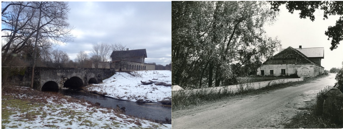
5. Vaade talu õuelt. Jõgeva kõrtsi kivisild 1. ja Jõgeva kõrtsi vare
