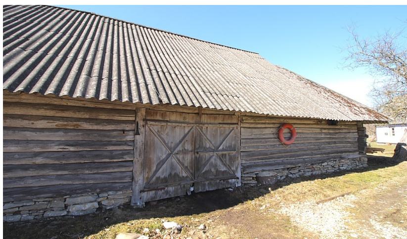
90. Vaade rehealusele tee poolt
