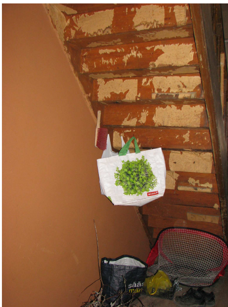
Foto 59. 1. korruse trepikoja seinapind.
