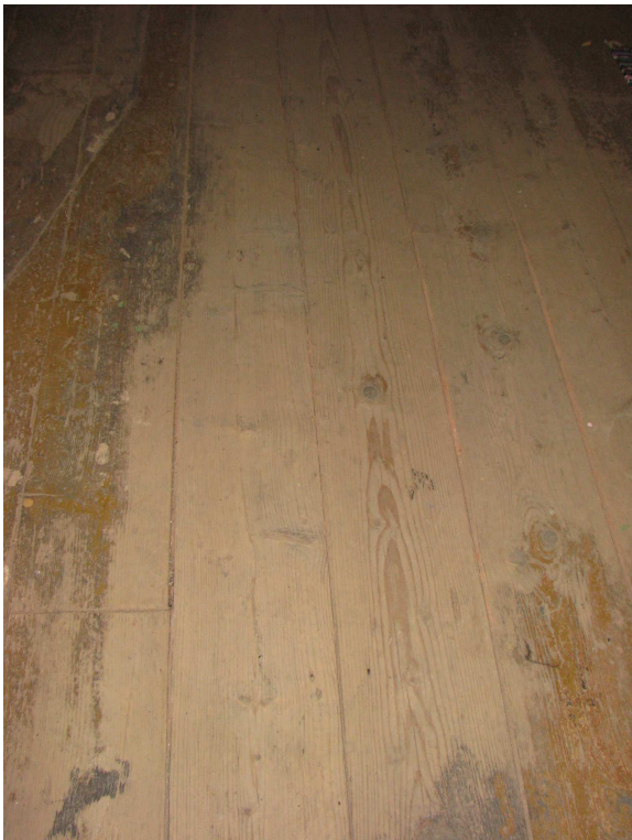
Foto 61. Esimese korruse trepikoja põrand.
