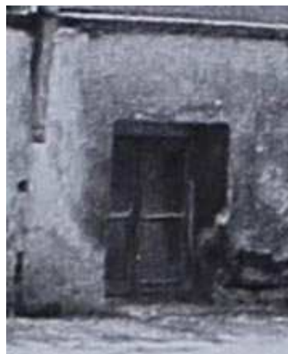
Foto 47. A5, keldriaken väljast. (1983. a., Rahvusarhiiv.)
