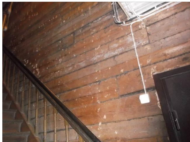
7 Foto 7.: Õle tn 10/1 vaade hoone fassaadile ja osalt tulemüürile, mis eraldab naaberhoonet antud hoonest. 8 Foto 8: Hoone kandesein, mis on ehitatud horisontaalselt asetatud puitpalkidest.
