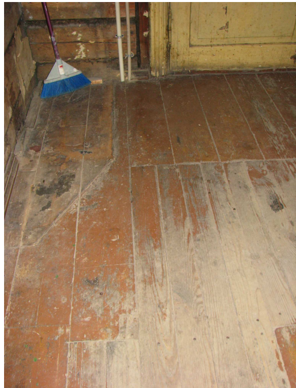
Foto 62. Teise korruse trepikoja põrand.
