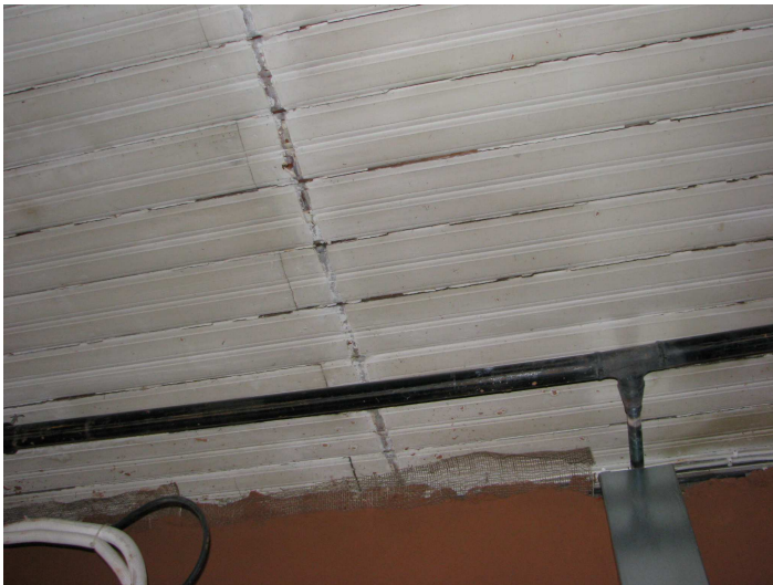
Foto 57. Esimese korruse trepikoja lagi.
