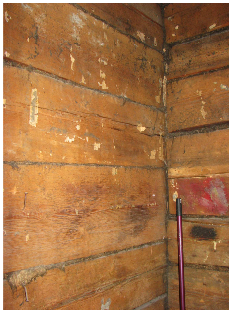
Foto 60. 2. korruse trepikoja seinapind.
