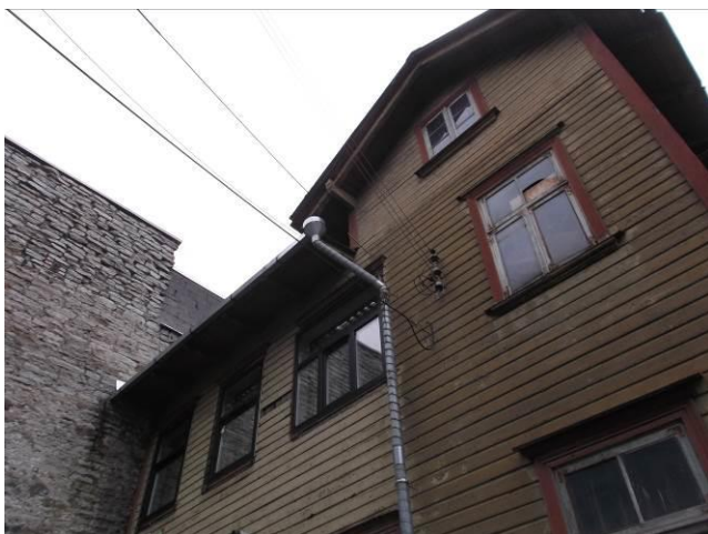
7 Foto 7.: Õle tn 10/1 vaade hoone fassaadile ja osalt tulemüürile, mis eraldab naaberhoonet antud hoonest. 8 Foto 8: Hoone kandesein, mis on ehitatud horisontaalselt asetatud puitpalkidest.
