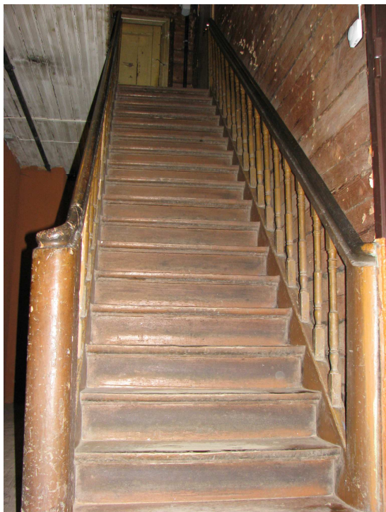
Foto 67. Puittrepp II korrusele.
